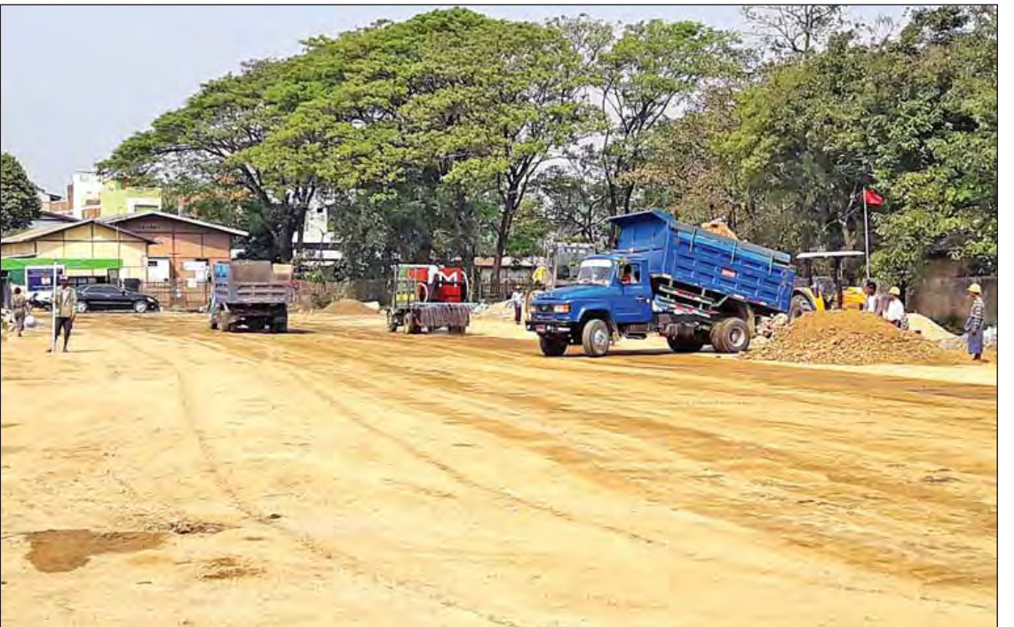
တပ်ကုန်းမြို့ ပျံကျဈေး ကွန်ကရစ်ခင်းခြင်းလုပ်ငန်း ဆောင်ရွက်နေသည်ကို တွေ့ရစဉ်။
