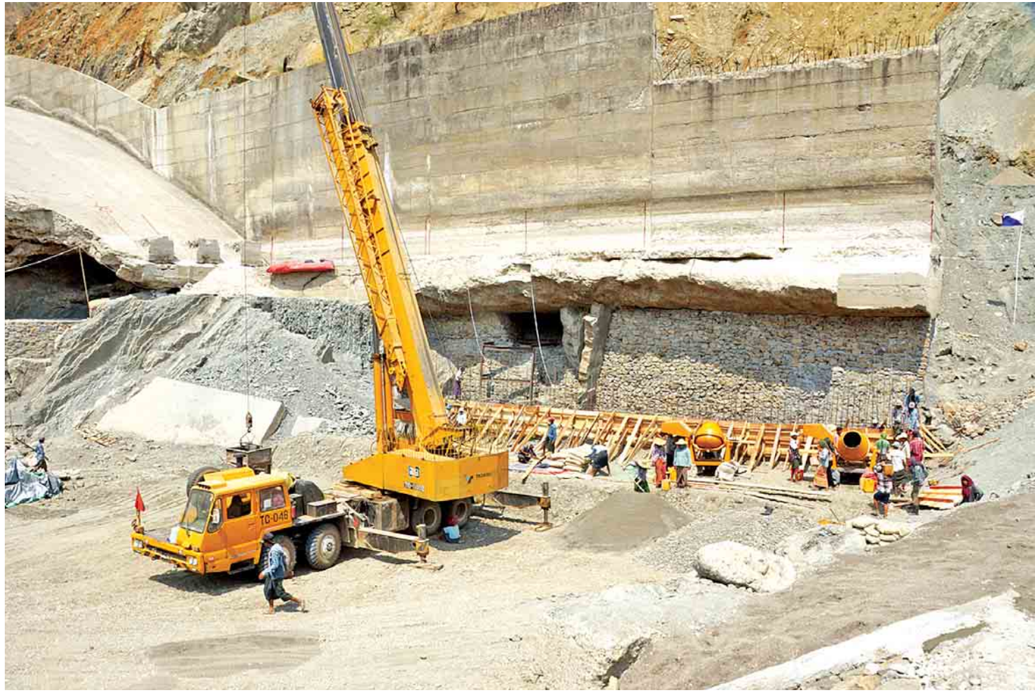
မကွေးတိုင်းဒေသကြီး ပွင့်ဖြူမြို့နယ် ကြီးအုံကြီးဝရေလှောင်တံခံ ရေပိုလွှဲချဲ့ထွင်ခြင်းနှင့် ပြုပြင်ခြင်းလုပ်ငန်းဆောင်ရွက်နေသည်ကို တွေ့ရစဉ်။
