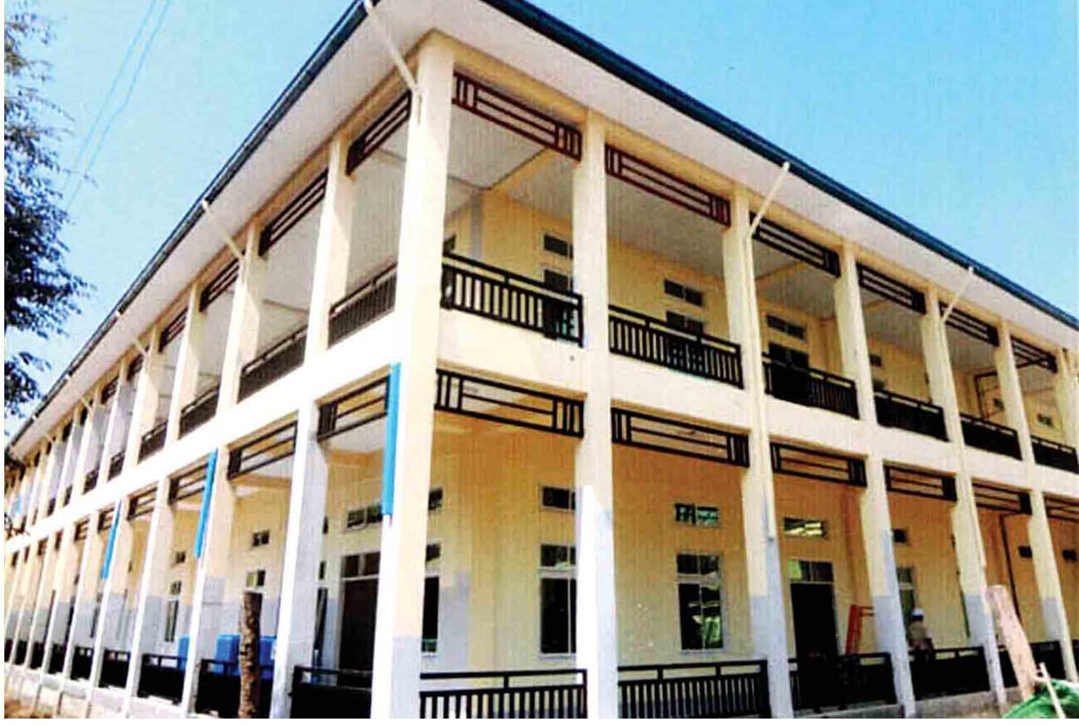
မကွေးတိုင်းဒေသကြီး စလင်းမြို့နယ် ခုတင် (၁၀၀) ဆုံဆေးရုံ တည်ဆောက်ပြီးစီးမှုအခြေအနေကို တွေ့ရစဉ်။
