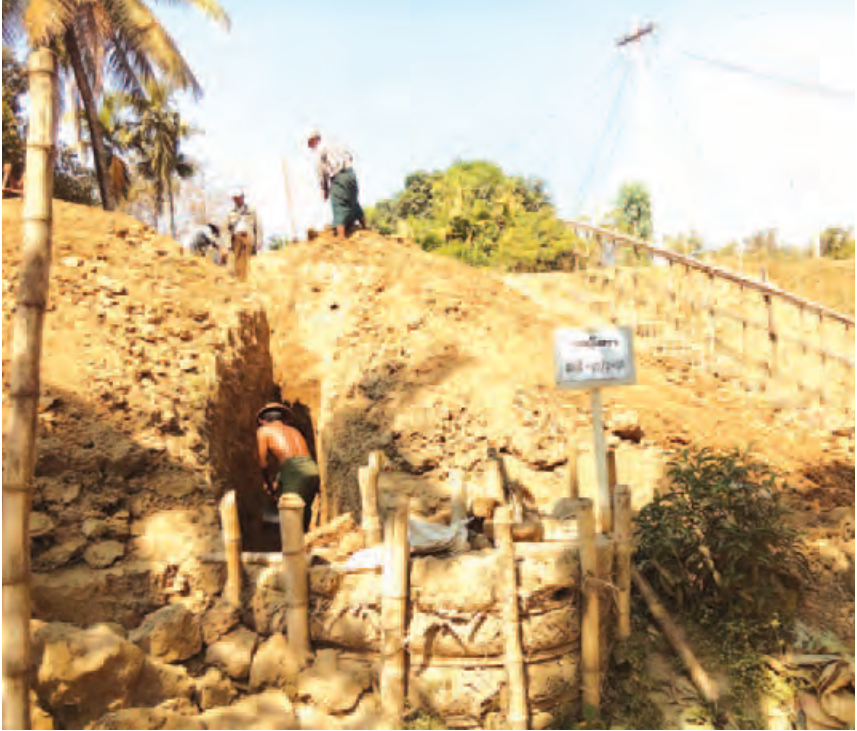
ရေယိုစိမ့်ပေါက် စုစုပေါင်း ၁၁ ပေါက် ပြုပြင်ဆောင် ရွက်ခဲ့ကြောင်း၊ အဆိုပါရေကာတာရေယိုစိမ့်ပေါက် မြေသား ပြုပြင်ခြင်းလုပ်ငန်းများအား ဖေဖော်ဝါရီ ၉ ရက်က အပြီးသတ်ဆောင်ရွက်သွားမည်ဖြစ် ကြောင်း ပြောကြားခဲ့သည်။
