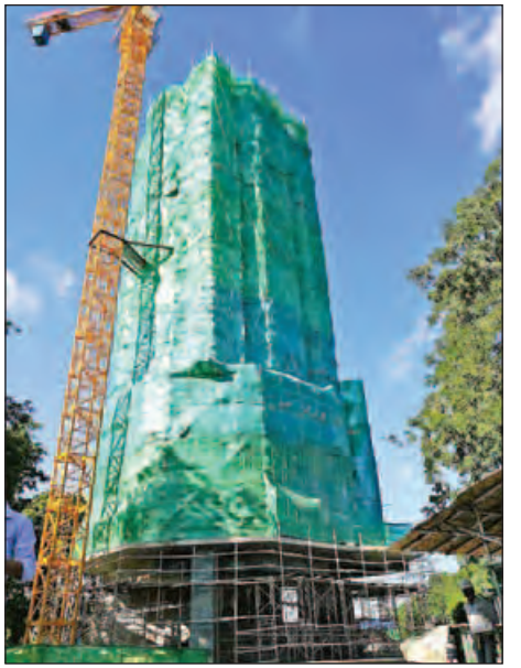
မိုးလေဝသတိုင်းတာရေး ရေဒါစခန်း (မန္တလေး) တည်ဆောက်နေမှုကို တွေ့ရစဉ်။
