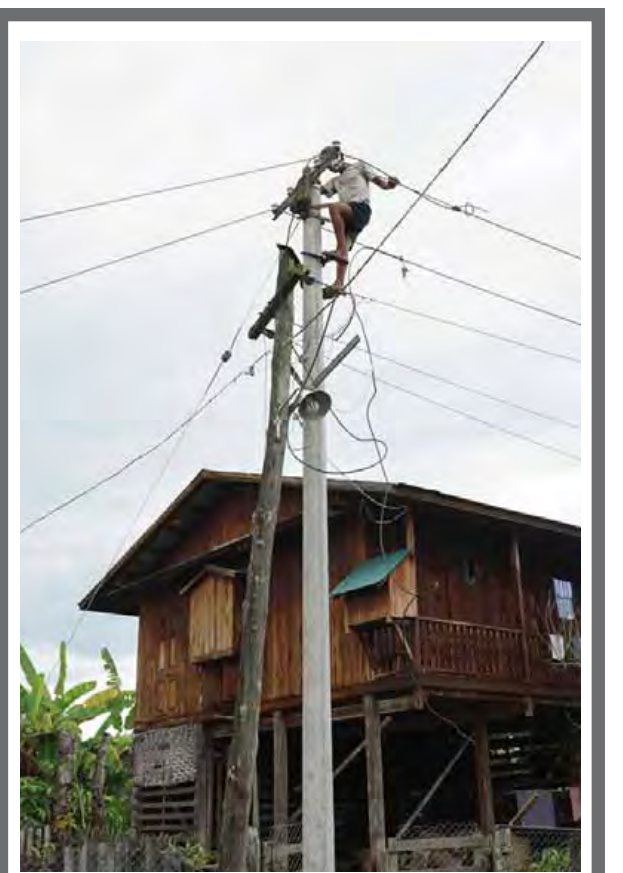
ပြည်သူများ လျှပ်စစ်အန္တရာယ်ကင်းစေရေး၊ ဓာတ်အားပြည့်ဝစွာရရှိရေးအတွက် စစ်ကိုင်းတိုင်းဒေသကြီး၊ အင်းတော်မြို့နယ် အောင်မေတ္တာရပ်ကွက်အတွင်းရှိ ဝင်ဒါဖီယာလမ်းမှ ဆွေးဖြည့်သစ်သားဓာတ်တိုင်ခြောက်တိုင်နှင့် နန်းဆီလမ်းရှိ ဆွေးဖြည့်သစ်သားဓာတ်တိုင် ခြောက်တိုင်တို့ကို ကွန်ကရစ်တိုင်အစုံဖြင့် အစားထိုးလဲလှယ်ခြင်း၊ ကေပယ်ကုတ်ကြိုးငါးကြိုး၊ အသစ်လဲလှယ်တပ်ဆင်ခြင်းလုပ်ငန်းများကို မြို့နယ်လျှပ်စစ်ဝန်ထမ်းများက အောက်တိုဘာ ၂၁ ရက်တွင် ဆောင်ရွက်ခဲ့ကြောင်းသိရသည်။ ကျော်မြင့်
