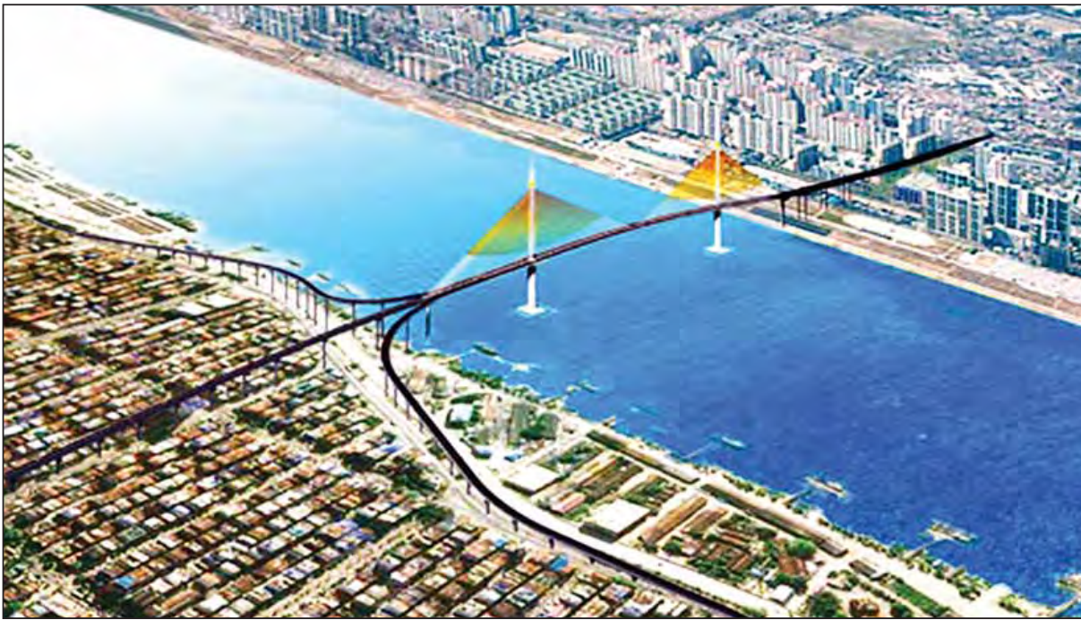
၂၀၁၇ ခုနှစ် နှစ်ကုန်ပိုင်းတွင် ရန်ကုန်မြို့နှင့် ဒလမြို့ကို ဆက်သွယ်တည်ဆောက်မည့် မြန်မာ-ကိုရီးယားချစ်ကြည်ရေး (ဒလ) တံတားပုံကြမ်းကို တွေ့ရစဉ်။ [သံမဏိကြီးဆိုင်း လေးလမ်းသွားတံတားဖြစ်ပြီး အမေရိကန်ဒေါ်လာ ၁၆၈ ဒသမ ၁၇၄ သန်း ခန့်မှန်းကုန်ကျမည်ဖြစ်ပြီး စီမံကိန်းကာလမှာ ၄၆ နှစ်ကြာမြင့်မည်ဖြစ်သည်။]
