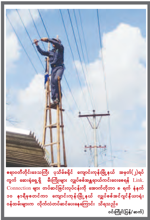
ရောဂါတိုင်းဒေသကြီး ပုသိမ်ခရိုင် ကျောင်းကျန်းမြို့နယ် အမှတ်(၂)ရပ် ကွက် ဆေးရုံရှေ့ရှိ မီးကြိုးများ လျှပ်စစ်အန္တရာယ်ကင်းစေရန် Link. Connection များ တပ်ဆင်ခြင်းလုပ်ငန်းကို အောက်တိုဘာ ၈ ရက် နံနက် ၁၀ နာရီမှစတင်ကာ ကျောင်းကျန်းမြို့နယ် လျှပ်စစ်အင်ဂျင်နီယာရုံး ဝန်ထမ်းများက လိုက်လံတပ်ဆင်ပေးနေကြောင်း သိရသည်။ ဝင်းကြိုင်(ပြန်/ဆက်)
