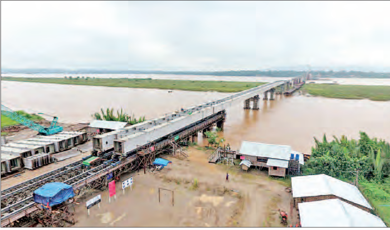
ဘီလူးကျွန်းနှင့် မော်လမြိုင်မြို့ကို ဆက်သွယ်တည်ဆောက်လျက်ရှိသော သံလွင်တံတား (ချောင်းဆုံ) တည်ဆောက်နေမှုမြင်ကွင်း။
