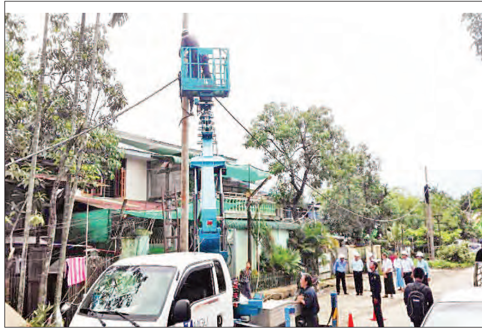
ရှုပ်ထွေးဆားပစ်ကြိုးများ ရှင်းလင်းရေးလုပ်ငန်း ဆောင်ရွက်နေမှုကို တွေ့ရစဉ်။
