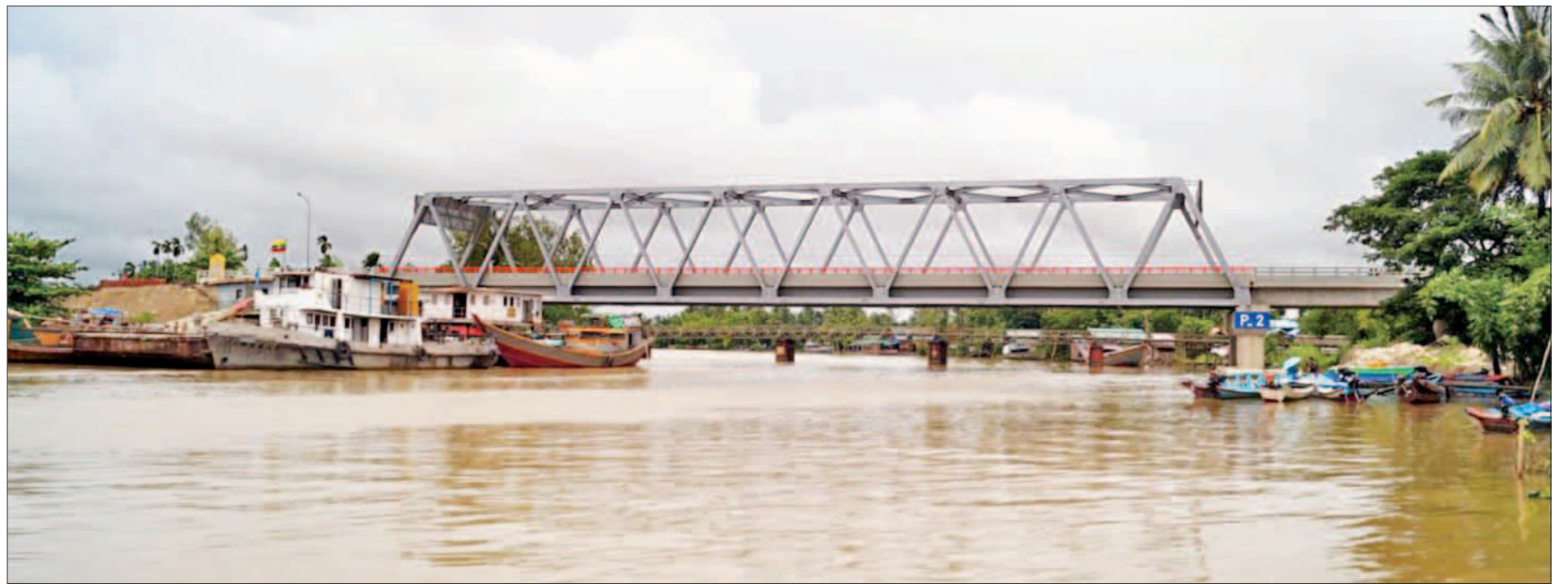
ဘိုကလေးမြို့အဝင်ရှိ နတ်ချောင်းတံတားတည်ဆောက်ပြီးစီးမှုကို တွေ့ရစဉ်။
