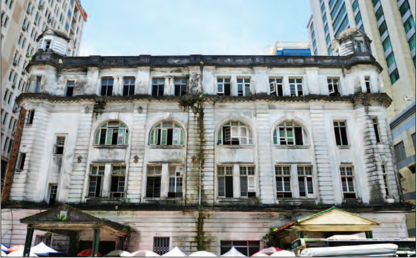
အမျိုးသားစာကြည့်တိုက်(ရန်ကုန်) ပြောင်းရွှေ့ဖွင့်လှစ်မည့် ရန်ကုန်မြို့ ပန်းဘဲတန်းမြို့နယ် အမှတ်(၆၀၄/ ၆၀၈)ကုန်သည်လမ်းရှိ အဆောက်အအုံကို လက်ရှိအခြေအနေအတိုင်း တွေ့ရစဉ်။
