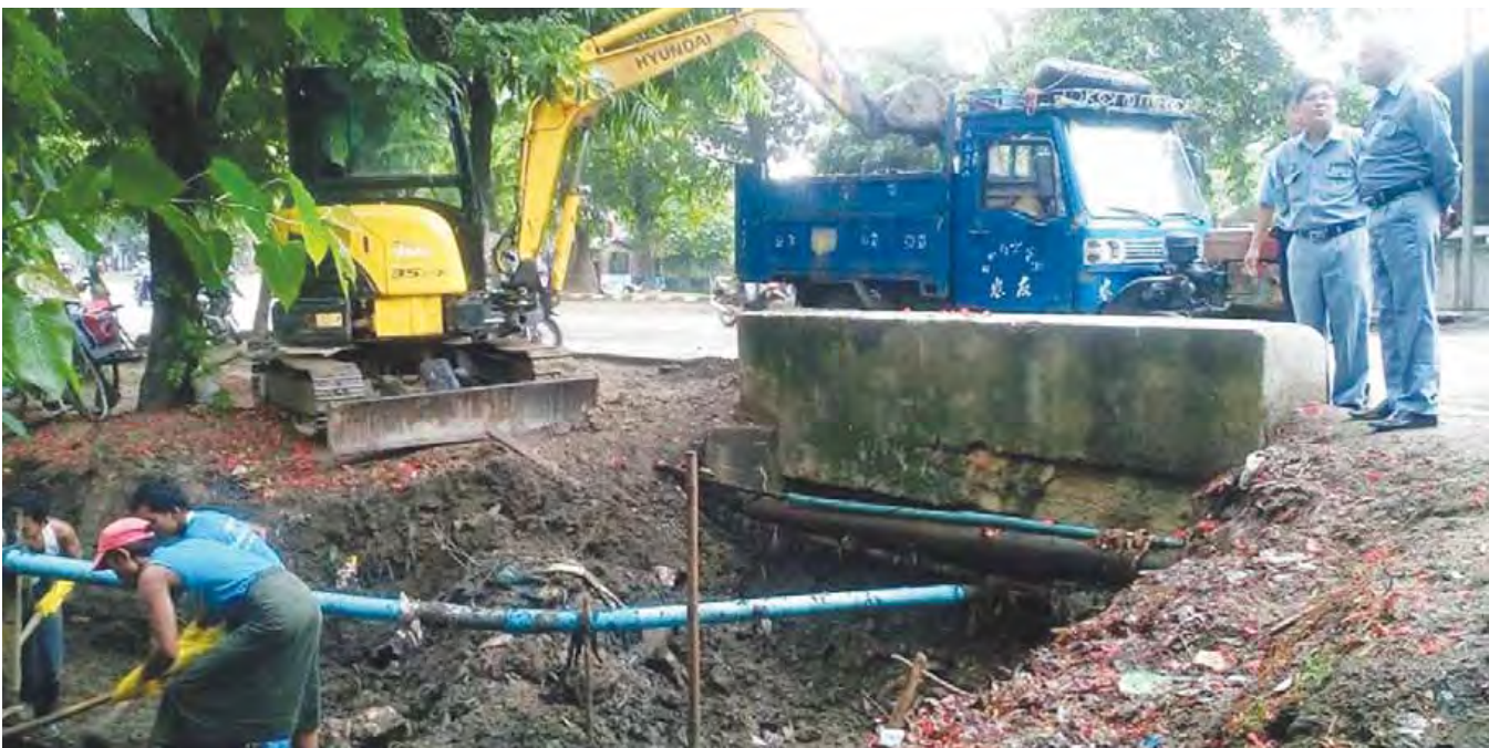
မကွေးတိုင်းဒေသကြီး သရက်ခရိုင် အောင်လံမြို့နယ်စည်ပင်သာယာရေးအဖွဲ့မှ ၂၀၁၆ ခု၊ ဇူလိုင်လလယ်ကလေးတွင် မြို့ရေစီးရေလျှော့ချရေးအဖွဲ့အစည်းမှ ဆောင်ရွက်လျက်ရှိရာ တရော်ကုန်းရပ်ကွက် ပြည်လမ်းအရှေ့ဘက်ခြမ်း ပင်မရေထုတ်မြောင်း ရေထွက်ပေါက်အား အဖွဲ့ဝင်စက်ယန္တရားဖြင့် တူးဖော်ရှင်းလင်းခြင်းလုပ်ငန်းကို မေ ၂၄ ရက်က မကွေးတိုင်းဒေသကြီးစည်ပင်သာယာရေးအဖွဲ့ ညွှန်ကြားရေးမှူး ဦးစိုးသန်း ကွင်းဆင်းစစ်ဆေးရာ အမှုဆောင်အရာရှိ ဦးမောင်မောင်အေးနှင့် အင်ဂျင်နီယာမှူး ဦးထွန်းသူအောင်တို့က ရှင်းလင်းတင်ပြခဲ့ကြောင်း သိရသည်။ သတင်းနှင့် ဓာတ်ပုံ - မိုးကိုကို (အောင်လံ)
