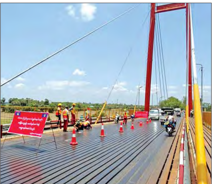
အတ္တရံတံတားကြမ်းခင်းကို ဆိုင်ကယ်များသွားနိုင်ရန် ပြုပြင်ထားပုံ။
