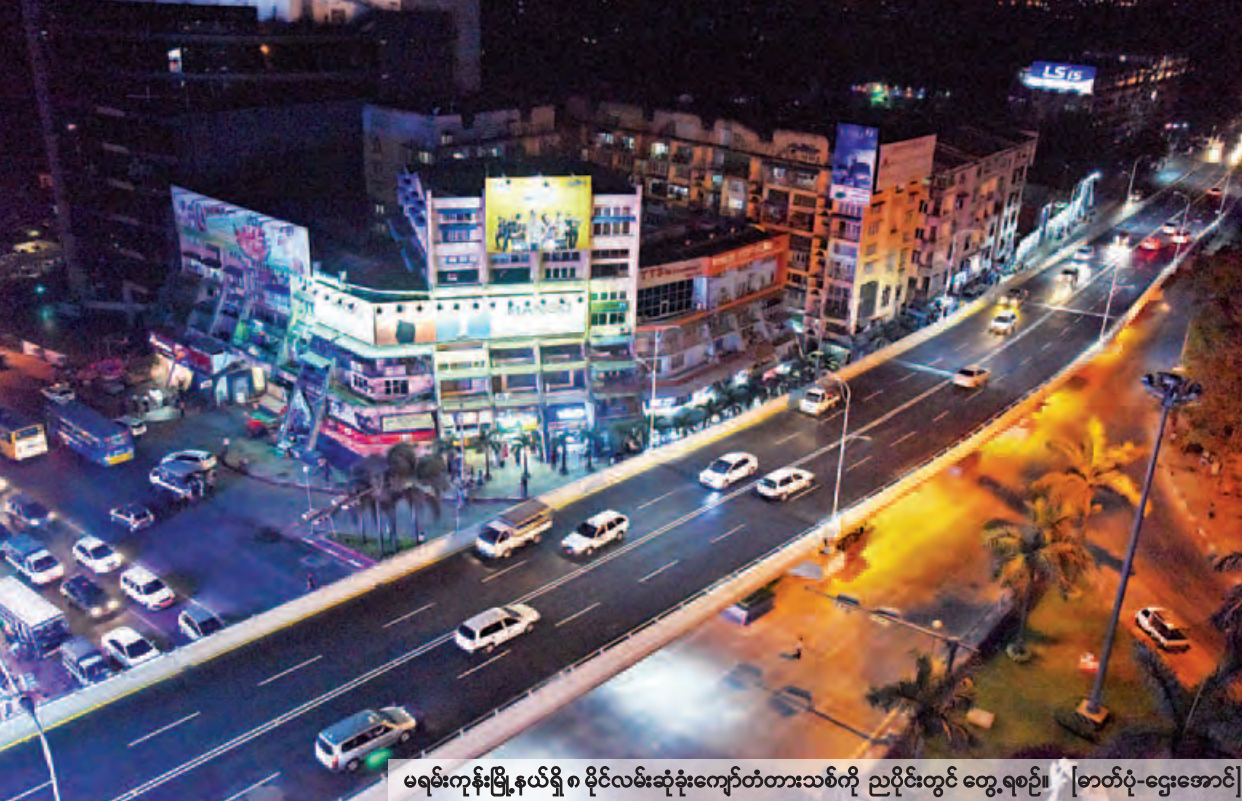
မရမ်းကုန်းမြို့နယ်ရှိ ၈ မိုင်လမ်းဆုံဆုံးကျော်တံတားသစ်ကို ညပိုင်းတွင် တွေ့ရစဉ်။ [ဓာတ်ပုံ-ဌေးအောင်]
