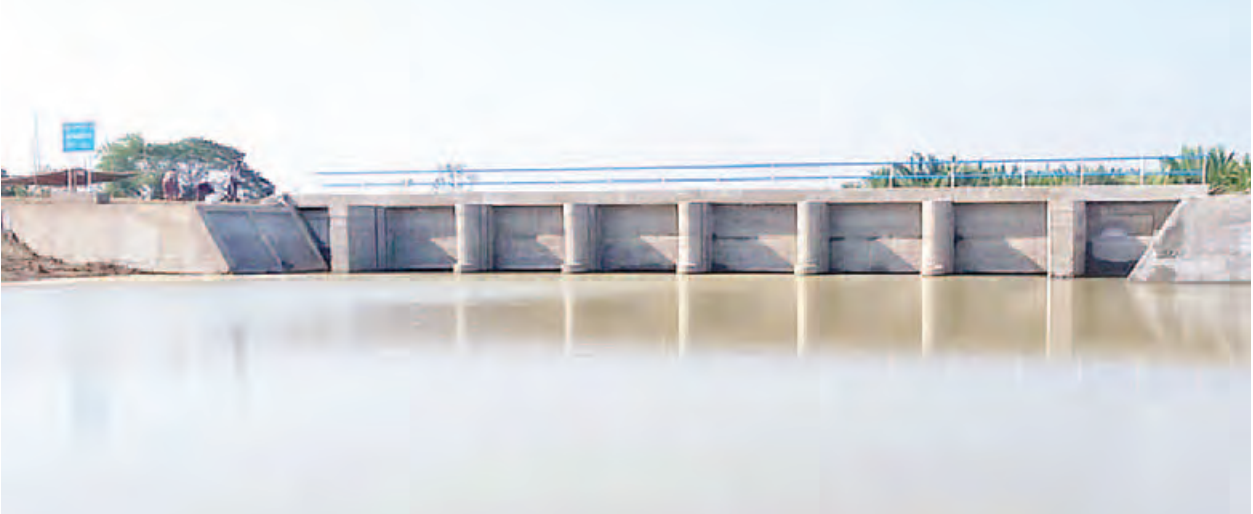
စံပုလဲရေတံခါးဟောင်း (၈ ပေ x ၈ ပေ - ၆ ပေါက်) ပြန်လည်ပြုပြင်ထားသည်ကို တွေ့မြင်ရစဉ်။
