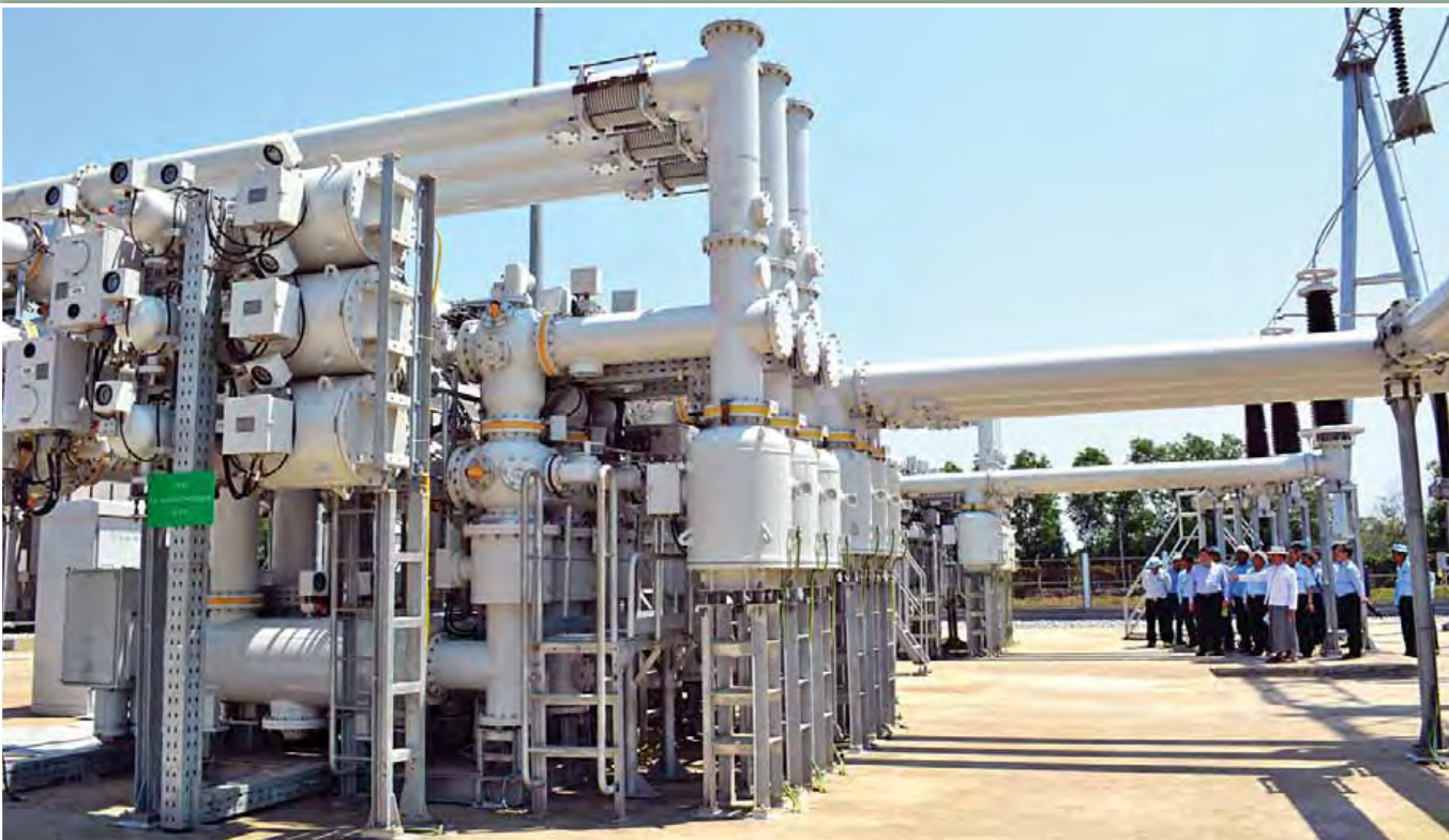
ရန်ကုန်တိုင်းဒေသကြီး ဒဂုံမြို့သစ်(အရှေ့ပိုင်း)မြို့နယ်တွင် တည်ဆောက်လျက်ရှိသည့် 230/66/11 KV (2 x 125) MVA(GIS) ဓာတ်အားခွဲခွဲကို မတ် ၈ ရက်က တွေ့ရစဉ်။ (သတင်း စာမျက်နှာ - ၅)
