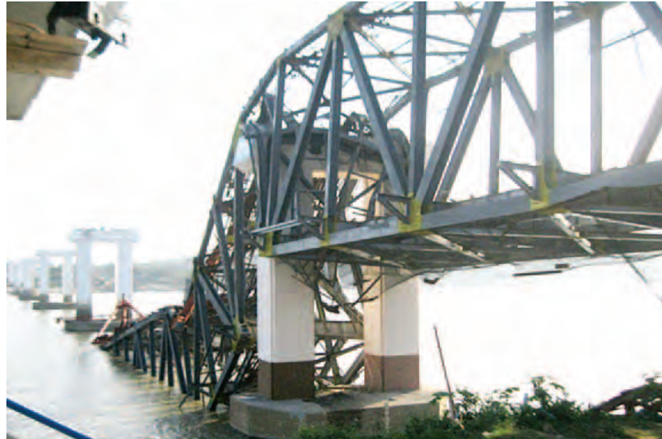
၂၀၁၂ ခုနှစ်တွင် သပိတ်ကျင်းမြို့၌ ရစ်ချ်တာစကေး ၆ ဒသမ ၈ ငလျင်ကြီးလှုပ်ခတ်မှုကြောင့် ရောဝတီမြစ်ကူး ရတနာသီလိတံတားပြိုကျပျက်စီးမှုအား တွေ့ရစဉ်။
