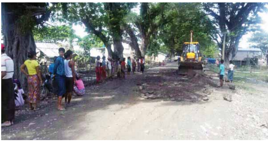
ကလေး-ပြင်သာ ကွန်ကရစ်လမ်းခင်းကျင်းရန် ၁၈-၉-၂၀၁၅ ရက်က ဆောင်ရွက်နေစဉ်။ (သတင်းစဉ်)
