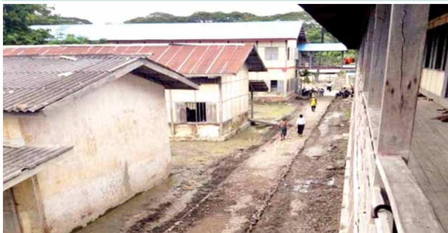
အထက(၁)ကလေး ကျောင်းဆောင်များအကြား ကွန်ကရစ်မခင်းမီ ၁-၁၀-၂၀၁၅ ရက်က တွေ့ရစဉ်။ (သတင်းစဉ်)
