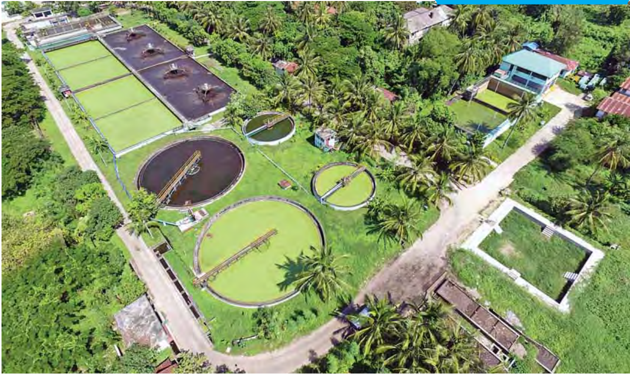
ရန်ကုန်(အရှေ့ပိုင်း)ခရိုင် ဗိုလ်တထောင်မြို့နယ် သန်လျက်စွန်းရုံ ရေဆိုးသန့်စင်စက်ရုံကို တွေ့ရစဉ်။
