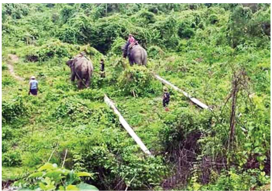
၆၆ ကေဗီ ပုသိမ်-ငရုတ်ကောင်း-ငပြေမ ဓာတ်အားလှိုင်းတိုင်ဆွဲခြင်းလုပ်ငန်း ဆောင်ရွက်နေမှုကို တွေ့ရစဉ်။
