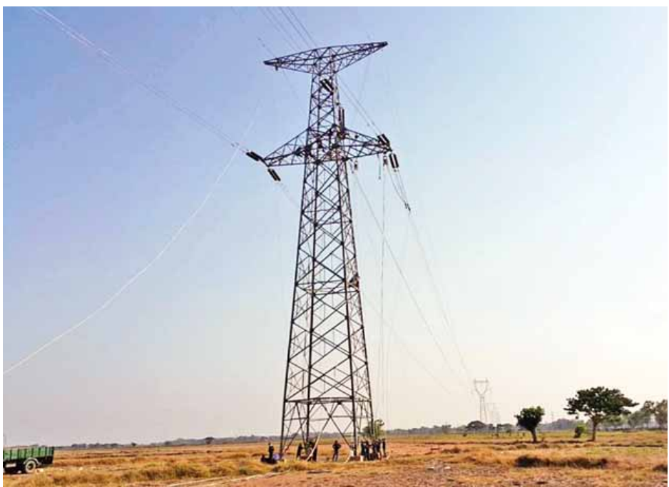
၂၃၀ ကေဗီ အသုတ်-ပုသိမ် မဟာဓာတ်အားလှိုင်းလုပ်ငန်း ဆောင်ရွက်နေမှုကို တွေ့ရစဉ်။
