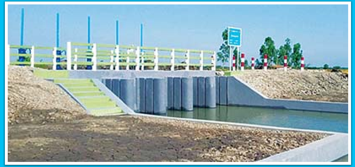
ရေန်ဒေသတွင် ပထမဆုံး စတင်အသုံးပြုသော သံချေးတက်ခြင်းမှ ကာကွယ်နိုင်သည့် Fiber Glass ရေတံခါးရွက် အသုံးပြုထားသည့် ရေဝတီတိုင်းဒေသကြီး ဖျာပုံမြို့နယ်အတွင်းရှိ ဦးလုံရေတံခါးအား ဒီဇင်ဘာ ၁၆ ရက်က တွေ့ရှိရပါ။
