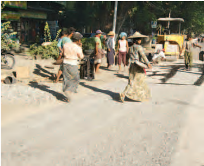
ကတ္တရာလမ်းမတစ်ဝက်ချဲ့၍ ကတ္တရာခင်းခြင်းလုပ်ငန်း ဆောင်ရွက်လျက်ရှိသည့် အပြင် မိုင်တိုင်အမှတ် (၁/၀) မှ (၂/၀) အတွင်း လမ်းအရှည် ၂၈၀၀ပေ၊ အကျယ် ၂၄ ပေ ကတ္တရာထပ်ပိုးလွှာခင်းခြင်း လုပ်ငန်းများကိုလည်း ဆောင်ရွက်လျက်ရှိကြောင်း သိရသည်။
