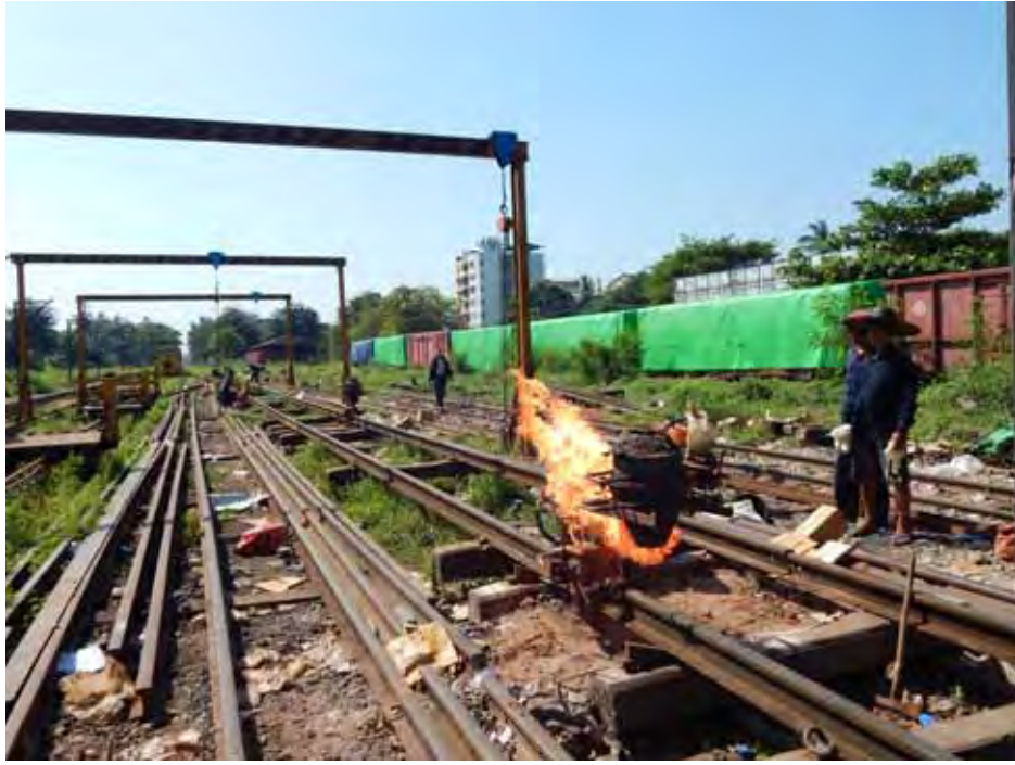
ကြည့်မြင်တိုင်ဘူတာ၌ ရထားသံလမ်းများ Thermit Welding ဆက်ခြင်းလုပ်ငန်းများဆောင်ရွက်နေသည်ကို တွေ့ရစဉ်။
