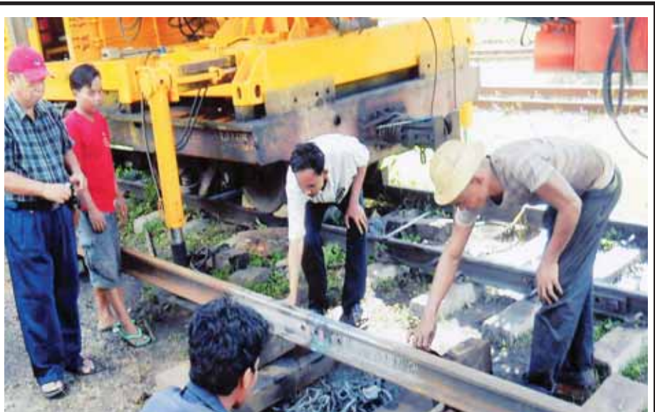
အင်ဂျင်နီယာမှူး ဦးကျော်လင်းနှင့် လ/ထ အင်ဂျင်နီယာဦးတင်မိုး (ဖြူ) တို့ ဦးဆောင်သော ကျွမ်းကျင်သံလမ်း လုပ်သားများက ရန်ကုန်-မန္တလေးရထားလမ်းပိုင်း အင်ဂျင်နီယာမြို့ပြတိုင်း (၆)နယ်မြေ အုတ်တွင်းမြို့နယ် ကျွဲပွဲနှင့် ညောင်ခြေထောက်ဘူတာအကြား မီးရထားအစုန်လမ်းပိုင်းတွင် လေးချောင်းတွဲ သံလမ်းများကို FFlash Ballt Welding စက်ဖြင့်ဆက်ပြီး အောက်တိုဘာ ပထမပတ်မှစတင်၍ အဆင့်မြှင့်တင်ဆောင်ရွက်လျက်ရှိရာ အောက်တိုဘာ ၂၃ ရက်အထိ တစ်မိုင်ခွဲခန့်ပြီးစီးပြီဖြစ်ကြောင်း သိရသည်။ (ဖြူမြင့်ဦး)
