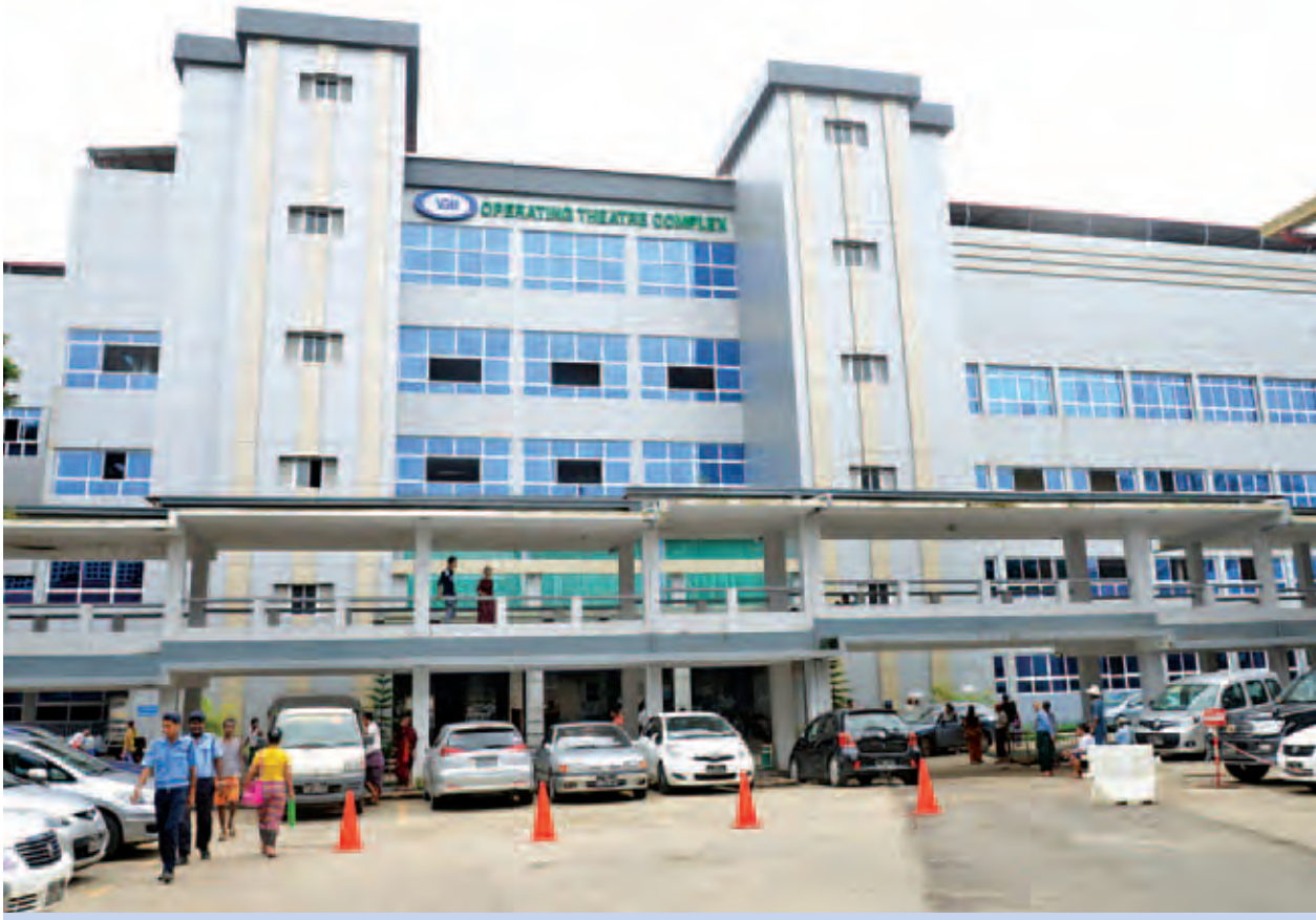
ရန်ကုန်ဆေးရုံကြီး တိုးချဲ့ငါးထပ်ဆောင်ကို တွေ့ရစဉ်။
