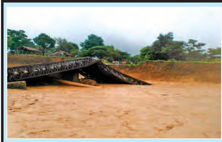
စစ်ကိုင်းတိုင်းဒေသကြီးအတွင်း ကလေး-ကျီးကုန်း-တမူးလမ်း မိုင်(၇၁/၂-၇၃/၃) ကြားရှိ တွဲပန်တံတား (၃/၇၂) ပေ ၂၁၀ ဘေလီတံတား ရေတိုက်စားမှုကြောင့် ပျက်စီးသွားသည်ကို တွေ့ရစဉ်။ (ဆောက်လုပ်ရေး)
