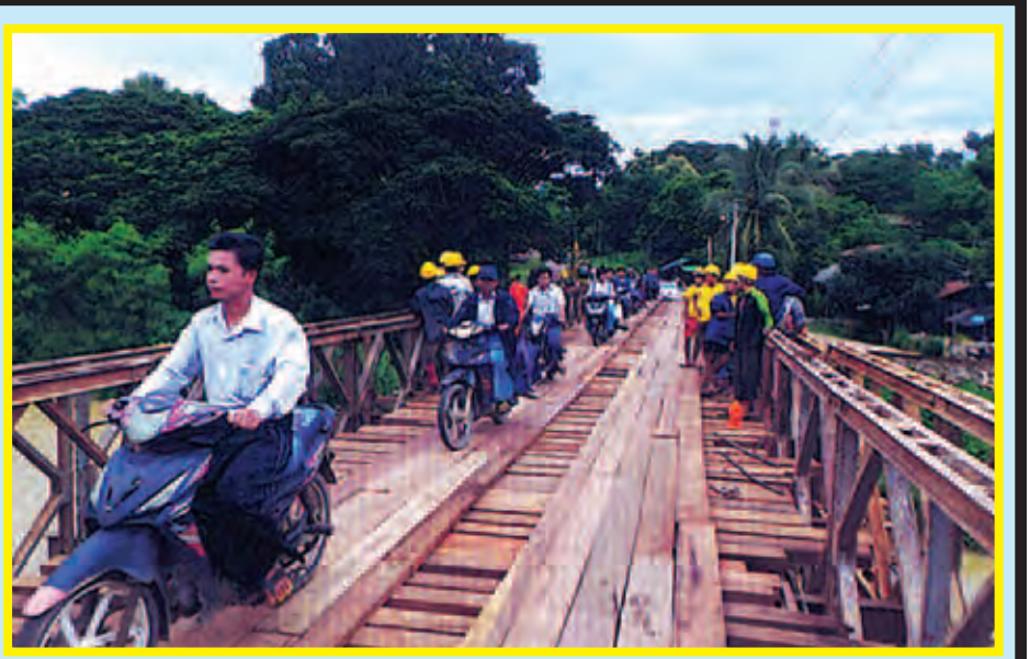
ဇူလိုင်နှင့်ဩဂုတ်လအတွင်း မိုးသည်းထန်စွာရွာသွန်းမှုကြောင့် ရှမ်းပြည်နယ်(မြောက်ပိုင်း)တွင် ပျက်စီးခဲ့သော သီပေါ-နမ့်တူလမ်းပေါ်ရှိ နမ့်ပေါတ်တား ပေ ၁၈၀ ဘေလီပေါင်များ တပ်ဆင်ပြီးစီး၍ ယာဉ်များ ဖြတ်သန်းနေစဉ်။ (ဆောက်လုပ်ရေး)
