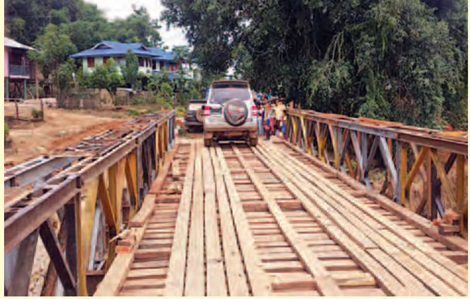
ဩဂုတ်လအတွင်း မိုးသည်းထန်စွာရွာသွန်းမှုကြောင့် ရှမ်းပြည်နယ်(အရှေ့ပိုင်း)တွင် ပျက်စီးခဲ့သော တာလေ-ပါသျှိုး-ကျိုင်းလပ်လမ်းတံတားအမှတ် (၁/၁၇)ဝမ်းမီးမိုင်တံတားအား 130 ft bailey bridge (90DS+ 40SS) တည်ဆောက်ပြီးစီး၍ မော်တော်ယာဉ်များဖြတ်သန်းနေစဉ်။ (ဆောက်လုပ်ရေး)
