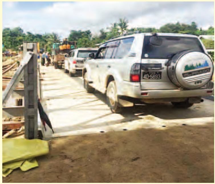
ဇူလိုင်လအတွင်းမိုးသည်းထန်စွာရွာသွန်းမှုကြောင့် စစ်ကိုင်းတိုင်းဒေသကြီးအတွင်း ပျက်စီးခဲ့သော ရွှေဘို-မြစ်ကြီးနားလမ်းပေါ်ရှိ ဟဲနတ်တား ပေ ၁၀၀ နှစ်လွှာတစ်ထပ် ဘောလီတံတား ဆောင်ရွက်ပြီးစီးပြီး ယာဉ်များဖြတ်သန်းနေစဉ်။ (ဆောက်လုပ်ရေး)
