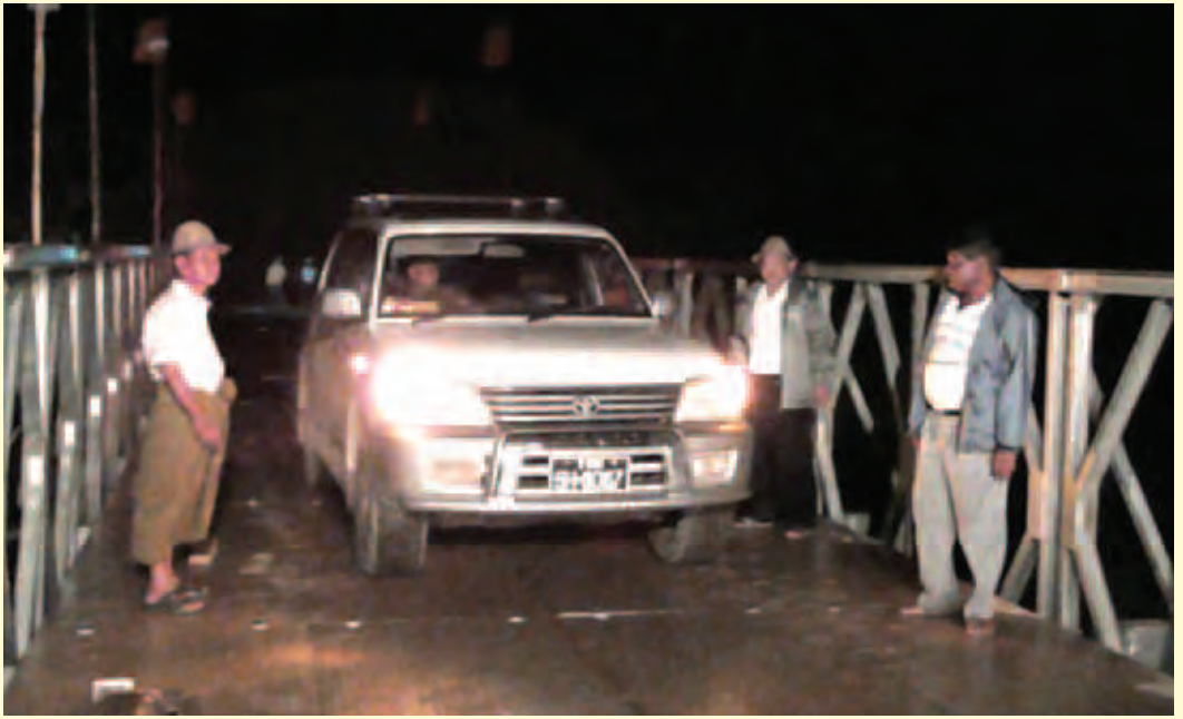
ဇွန်လနှင့် ဇူလိုင်လအတွင်းမိုးသည်းထန်စွာရွာသွန်းမှုကြောင့် ရခိုင်ပြည်နယ်အတွင်း ပျက်စီးခဲ့သော သံတွဲ-ဂွလမ်းမိုင် (၂၆/၇)-(၂၇/၀) ကြားတံတားအမှတ် (၁၀/၂၇) ပေ ၁၄၀ ရှည် တစ်လွှာတစ်ထပ်ဘောလီတံတား လုပ်ငန်းဆောင်ရွက်ပြီးစီးမှုကို တွေ့ရစဉ်။ (ဆောက်လုပ်ရေး)
