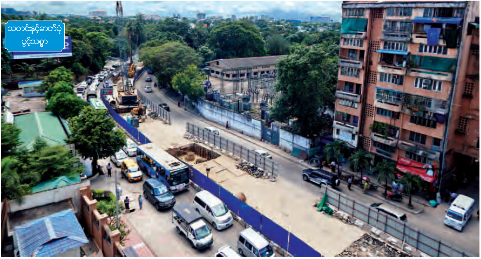
ရှစ်မိုင်လမ်းဆုံ ခုံးကျော်တံတားသစ်စီမံကိန်းဆောင်ရွက်နေမှုကို တွေ့ရစဉ်။
