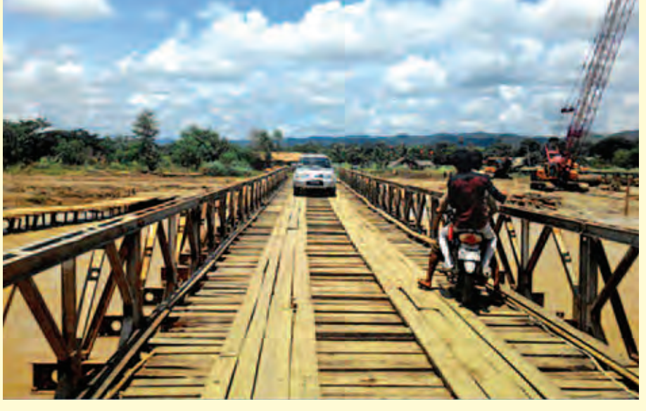
ဇူလိုင်လအတွင်း မိုးသည်းထန်စွာရွာသွန်းမှုကြောင့် မကွေးတိုင်းဒေသကြီးအတွင်း ပျက်စီးခဲ့သော ငမဲ-စေတုတ္တရာ လမ်းပေါ်ရှိ မန်းချောင်းတံတား ယာယီဘောလီတံတား တည်ဆောက်ပြီး၍ ယာဉ်များဖြတ်သန်းနေစဉ်။ (ဆောက်လုပ်ရေး)
