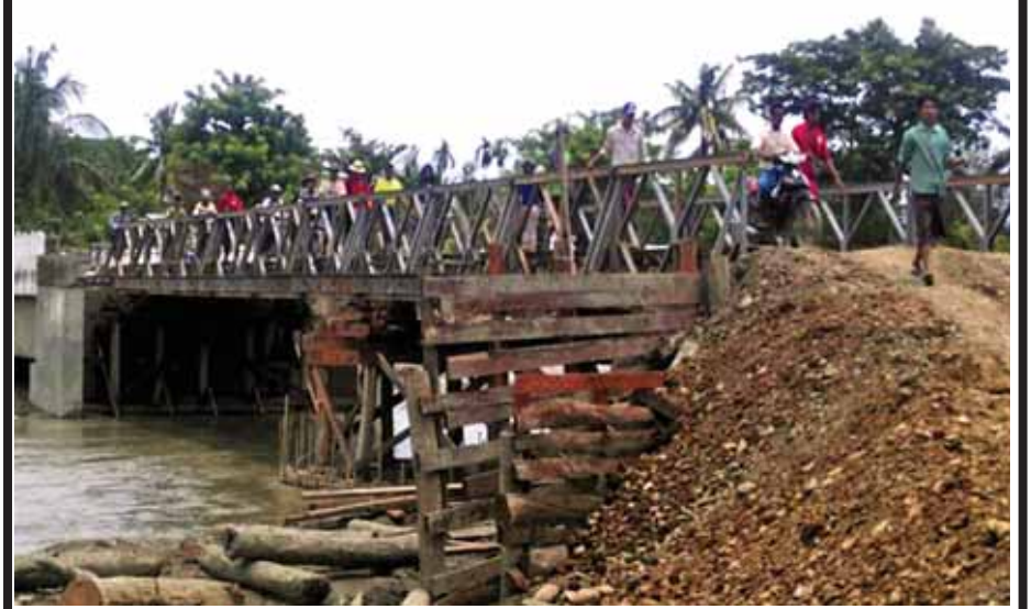
ဇူလိုင်လအတွင်း မိုးသည်းထန်စွာ ရွာသွန်းမှုကြောင့် စစ်ကိုင်းတိုင်းဒေသကြီး၌ ပျက်စီးခဲ့သော ဂန့်ဂေါ-ကလေးလမ်း မိုင် (၇၈/၃)-(၇၈/၄) ဇင်ကလင်းတံတား မူလပေ ၁၁၀ မှ ချဉ်းကပ်လမ်း ရေတိုက်စားသွားသည့် အပိုင်းအား ပေ ၁၀၀ ဘေးလိတ်တား ထပ်တိုးတည်ဆောက်ခြင်းလုပ်ငန်းဆောင်ရွက်ပြီးစီး၍ ဖြတ်သန်းသွားလာ နေကြစဉ်။ (ဆောက်လုပ်ရေး)
