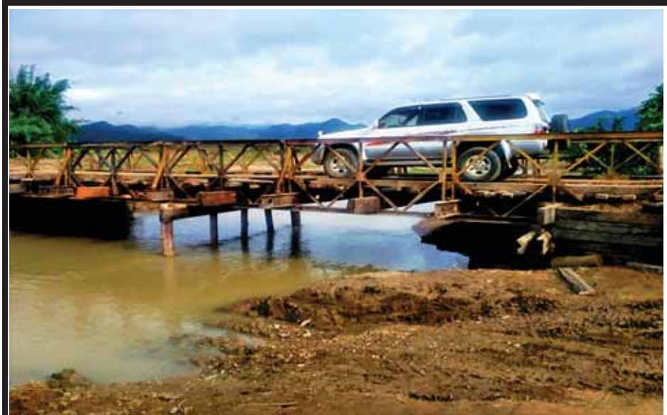
ဇူလိုင်လအတွင်း မိုးသည်းထန်စွာ ရွာသွန်းမှုကြောင့် စစ်ကိုင်းတိုင်းဒေသကြီး၌ ပျက်စီးခဲ့သော မိုင် (၁၈/၀)- (၁၈/၁)ကြား တံတားအမှတ် (၁/၁၉) နန်းတီဆင်းတံတား ပေ ၁၆၀ ယာယီရေနိမ့်ဘေးလိတ်တား ဆောင်ရွက်ပြီးစီးစဉ်။ (ဆောက်လုပ်ရေး)
