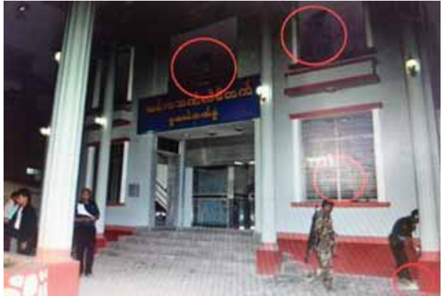
အဆိုပါ ဘဏ်သည် အုတ်ကာသွပ်မိုး သုံးထပ်အဆောက်အအုံဖြစ်ပြီး ဘဏ်တွင် မူဆယ်ဘဏ်ခွဲမန်နေဂျာ ဒေါ်ခင်နီနီကို အပါအဝင် အမျိုးသမီး ဝန်ထမ်း ၁၁ ဦးတို့ ညအိပ်နေထိုင်ကြောင်း ဘဏ်လုံခြုံရေး(ညစောင့်) ထားရှိခြင်းမရှိကြောင်း သိရသည်။ (ရိုးသွား)
