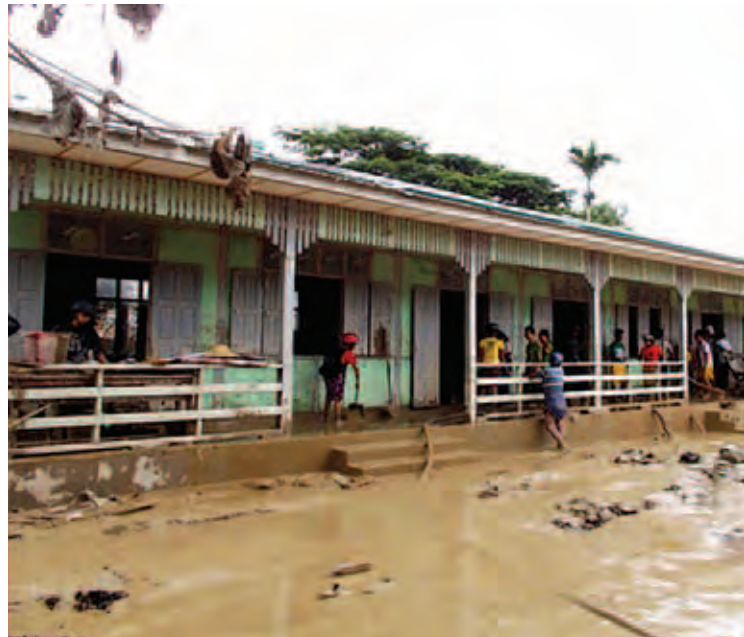
ကလေးမြို့ အမှတ်(၁၀)အခြေခံပညာအလယ်တန်းကျောင်းကို ရွှံ့ညွှန်များ ဖယ်ရှား ခြင်းလုပ်ငန်း ဆောင်ရွက်နေစဉ်။
