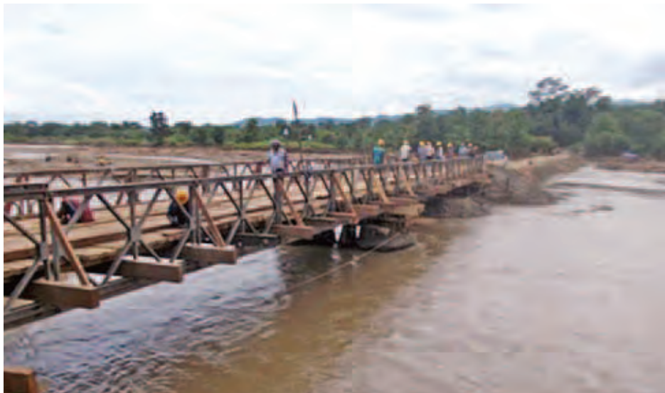
မိုင်တိုင်(၅၇/၅-၅၇/၆)ကြား တံတားအမှတ်(၃/၅၈) (ကနန်တံတား) ယာယီရေနိမ့်ဘေလီတံတား ဆောင်ရွက်ပြီးစီးမှုကို တွေ့ရစဉ်။
