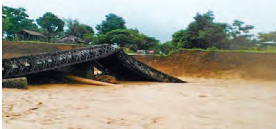
ကလေးဝ-ကျီးကုန်း-တမူးလမ်း မိုင်(၇၀/၃-၇၀/၄)ကြား တို့ဗန်တံတား တံတားအမှတ်(၃/၇၂) ချောင်းရေ တိုက်စားမှုကို တွေ့ရစဉ်။ (ပြန်/ဆက်)
