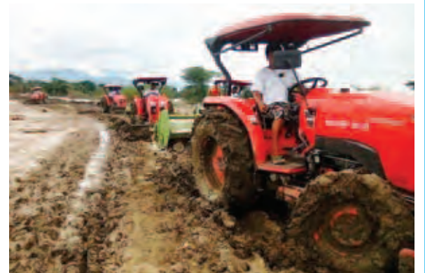
စစ်ကိုင်းတိုင်းဒေသကြီး ကလေးမြို့နယ် ထိုမာကျေးရွာ လမ်းပေါ်မှ နန်းများ ဖယ်ရှားဆောင်ရွက်ပေးနေစဉ်။
