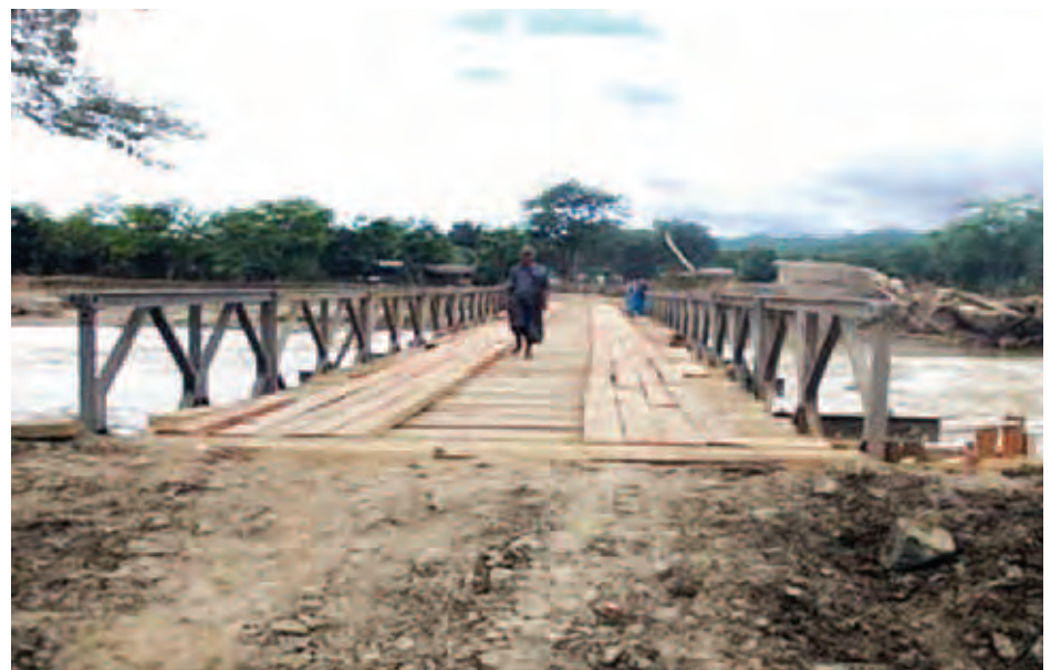
ကလေးဝ-ကျီးကုန်း-တမူးလမ်းပေါ်ရှိ ကမ္ဘာကြီးတံတား(၄/၆၂)ဆောင်ရွက်ပြီးစီးမှုကို တွေ့ရစဉ်။ (ပြန်/ဆက်)
