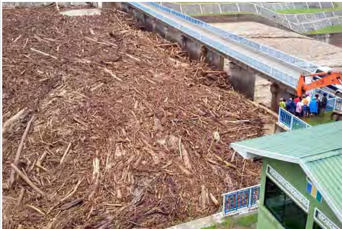
ရာဇဂြိုဟ်ရေလှောင်တံစံ ရေပိုလွှဲတွင် သစ်တုံးများ၊ အမှိုက်များ ပိတ်နေစဉ်။
