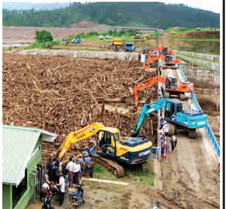
ရာဇဂြိုဟ်ရေလှောင်တံစံ ရေပိုလွှဲတွင် ပိတ်နေသည့် သစ်တုံးများ၊ အမှိုက်များအား စက်ယန္တရားများဖြင့် ရှင်းလင်းနေစဉ်။
