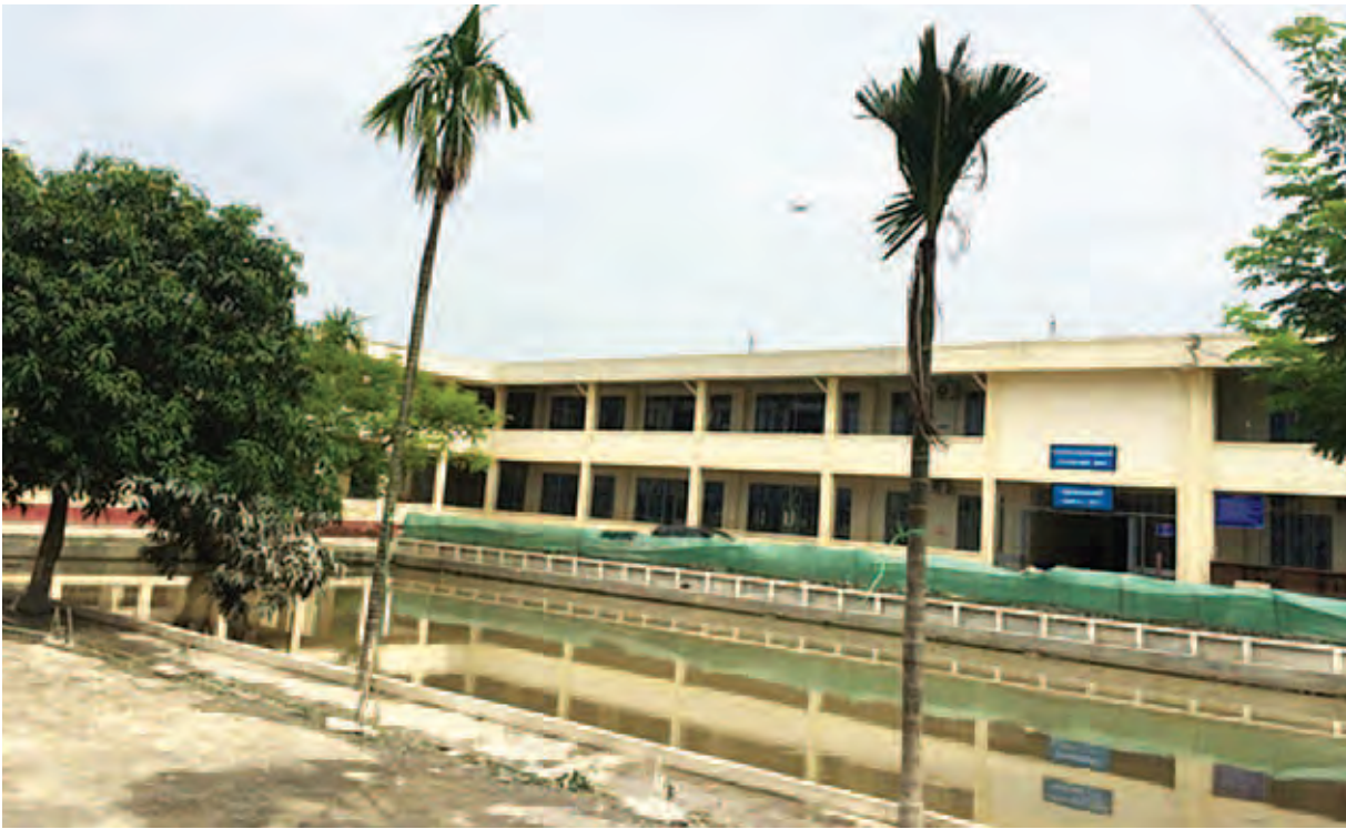
ကလေးမြို့၊ ပြည်သူ့ဆေးရုံ ကလေးကုသဆောင်နှင့် ပတ်ဝန်းကျင်သန့်ရှင်းရေးလုပ်ငန်းများ ဆောင်ရွက်ထားမှုကိုတွေ့ရစဉ်။
