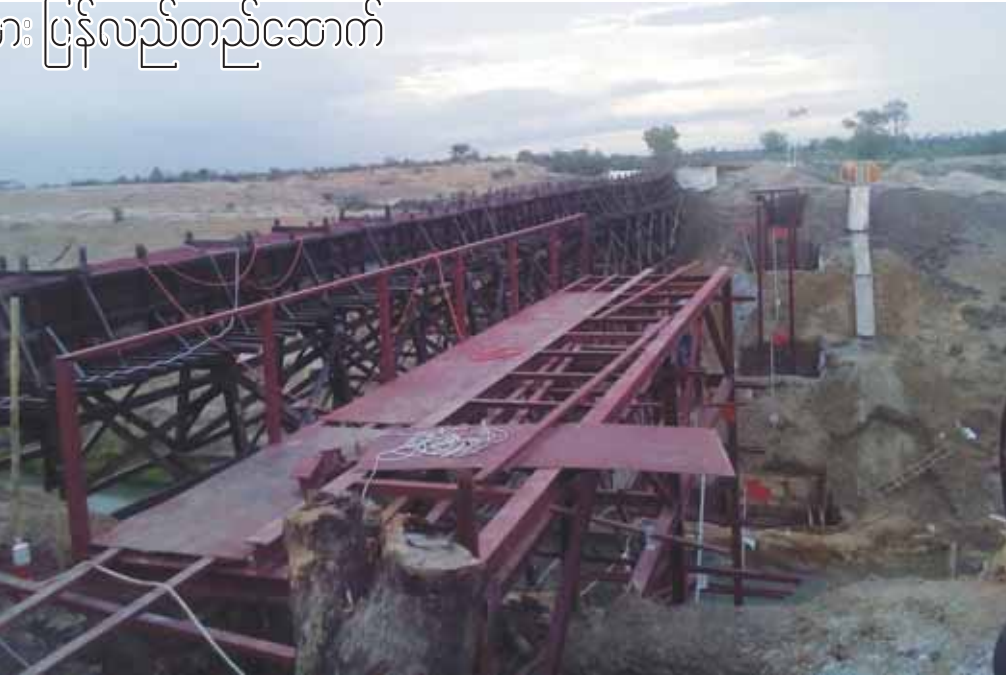
နဲ့ စိုက်ပျိုးရသလောက်ဧကလေးတွေကို စိုက်ပျိုးနေကြတာပဲ” ဟု ပြောသည်။ လင်းဇင်းဆည်ရေသောက်စနစ် စလင်းမြောင်းမကြီးလက်တံ ၃ မြောင်း သစ်သားရေတံလျှောက်မှ စိုက်ပျိုးရေးကို အသုံးပြုရသော လယ်ဧကပေါင်း ၈၅၀ ခန့်ရှိရာ ရေတံခံနိုင်ရည်အားနည်း၍ စိုက်ပျိုးရေးလုပ်ကိုင်စွာမရရှိသော်လည်း ခိုင်ခံ့သည့် စတီးရေတံလျှောက် ဆောက်လုပ်ပြီးစီးသွားပါက စိုက်ဧကများကို ဆည်ရေလုံလောက်စွာ ပေးသွားနိုင်တော့မည်ဖြစ်ကြောင်း စလင်းမြို့နယ် ဆည်မြောင်းဦးစီးဌာနမှ သိရသည်။ ဦးစေ(မဏ္ဍရာ)
