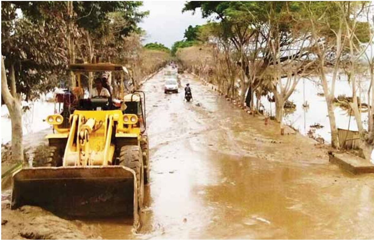
ကလေး-ကျီကုန်းလမ်းပိုင်းတွင် တင်ကျန်နေသော ရွှံ့ညွှန်များအား စက်ယန္တရားများဖြင့် ရှင်းလင်းဖယ်ရှားနေစဉ်။
