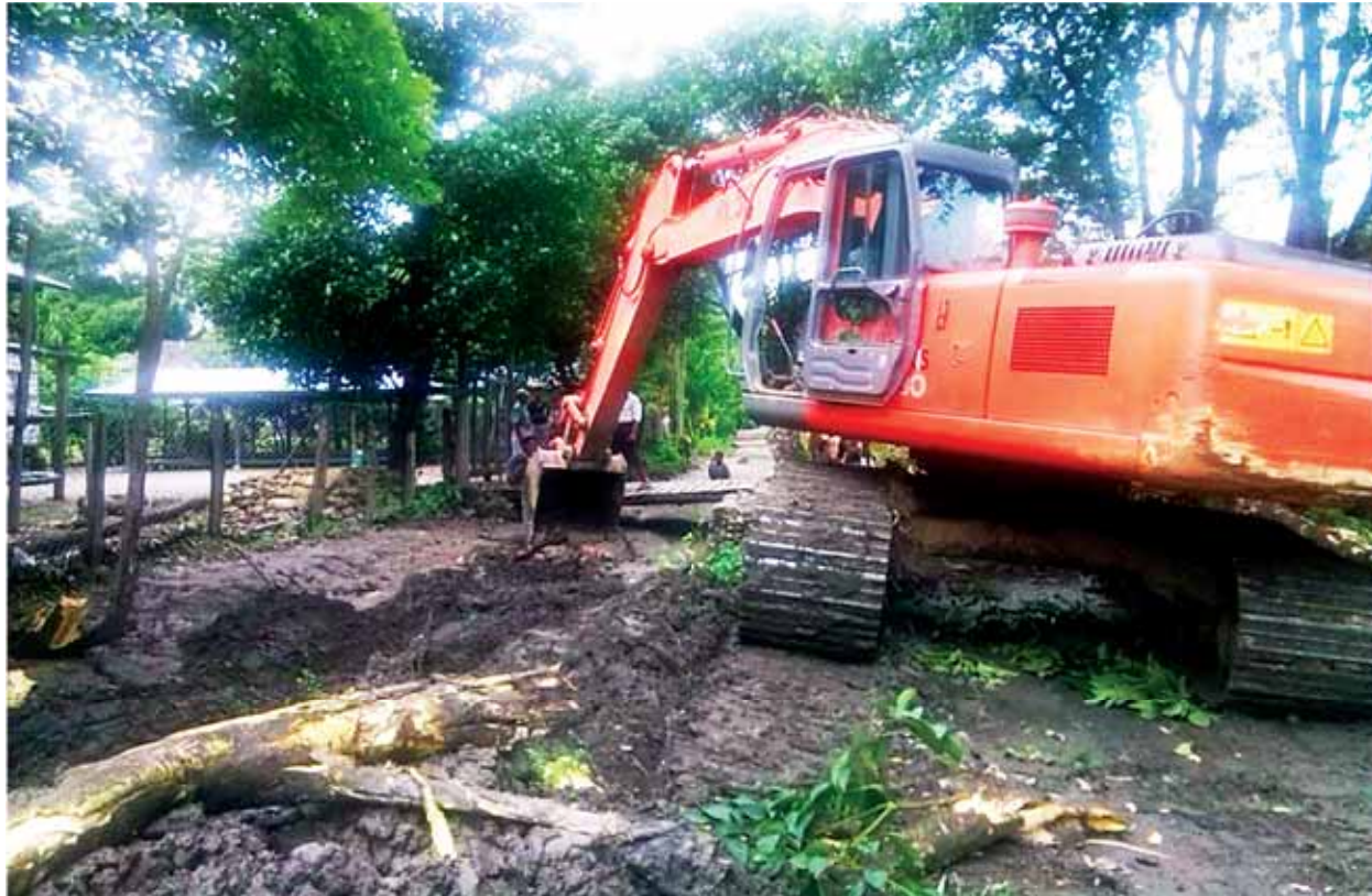
ကလေးမြို့နယ်တွင် ပြန်လည်ထူထောင်ရေးလုပ်ငန်းများအတွက်ဆည်မြောင်းဦးစီးဌာနမှ ရေမြှုပ်ခဲ့သော ရေနုတ်မြောင်းများအတွင်းရှိ အမှိုက်များ၊ သဲ၊ နန်း တူးဖော်ဖယ်ရှားခြင်းလုပ်ငန်းများကို စက်ယန္တရားကြီးများဖြင့် ဆောင်ရွက်နေသည်ကို ဩဂုတ် ၁၃ ရက်က တွေ့ရစဉ်။
