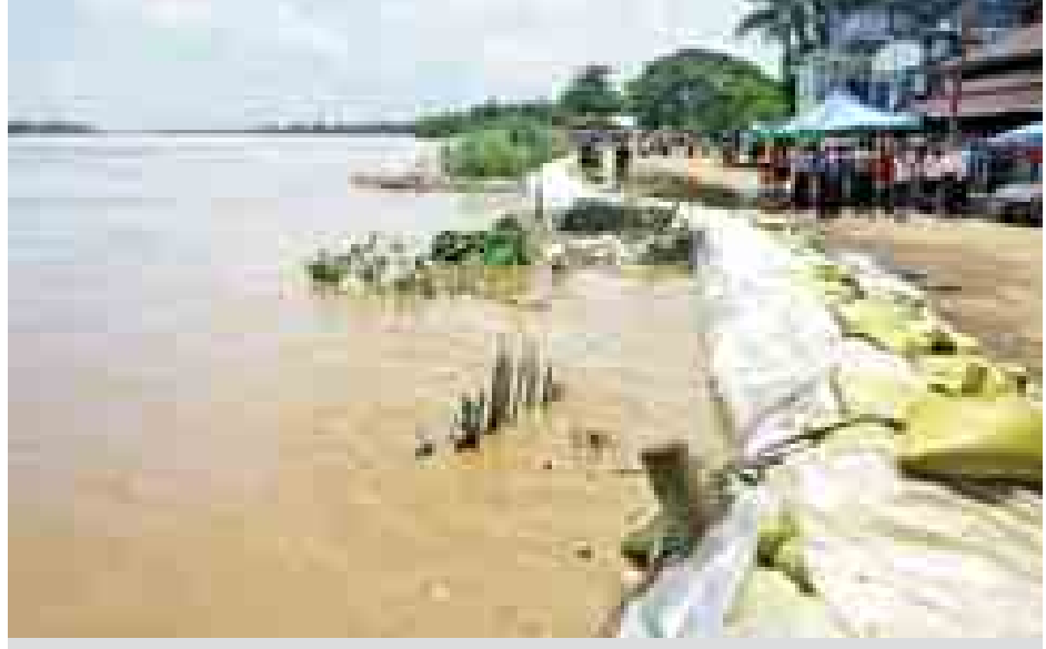
ဧရာဝတီမြစ်ရေမဝင်ရောက်နိုင်ရန် ရေကာတာတံဆောင်ရွက်ထားမှုကို တွေ့ရစဉ်။
