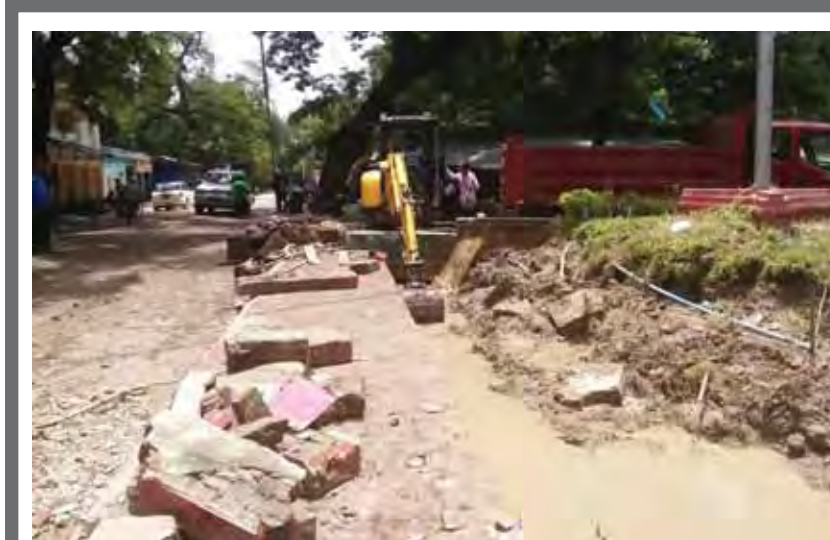
မကွေးတိုင်းဒေသကြီး မင်းဘူးခရိုင် ဖွင့်မြို့မြို့ပေါ်ရပ်ကွက်များတွင် ရေကြီးရေလျှံမှုများကြောင့် ရေနုတ်မြောင်းများပိတ်ဆို့နေခြင်းကို ဖွင့်မြို့မြို့နယ် စည်ပင်သာယာရေးအဖွဲ့ဝန်ထမ်းများက သန့်ရှင်းရေးပြုလုပ်၍ မြေကော်စက်ကြီးများဖြင့် အမြန်တူးဖော်ဆောင်ရွက်နေကြောင်း သိရသည်။
