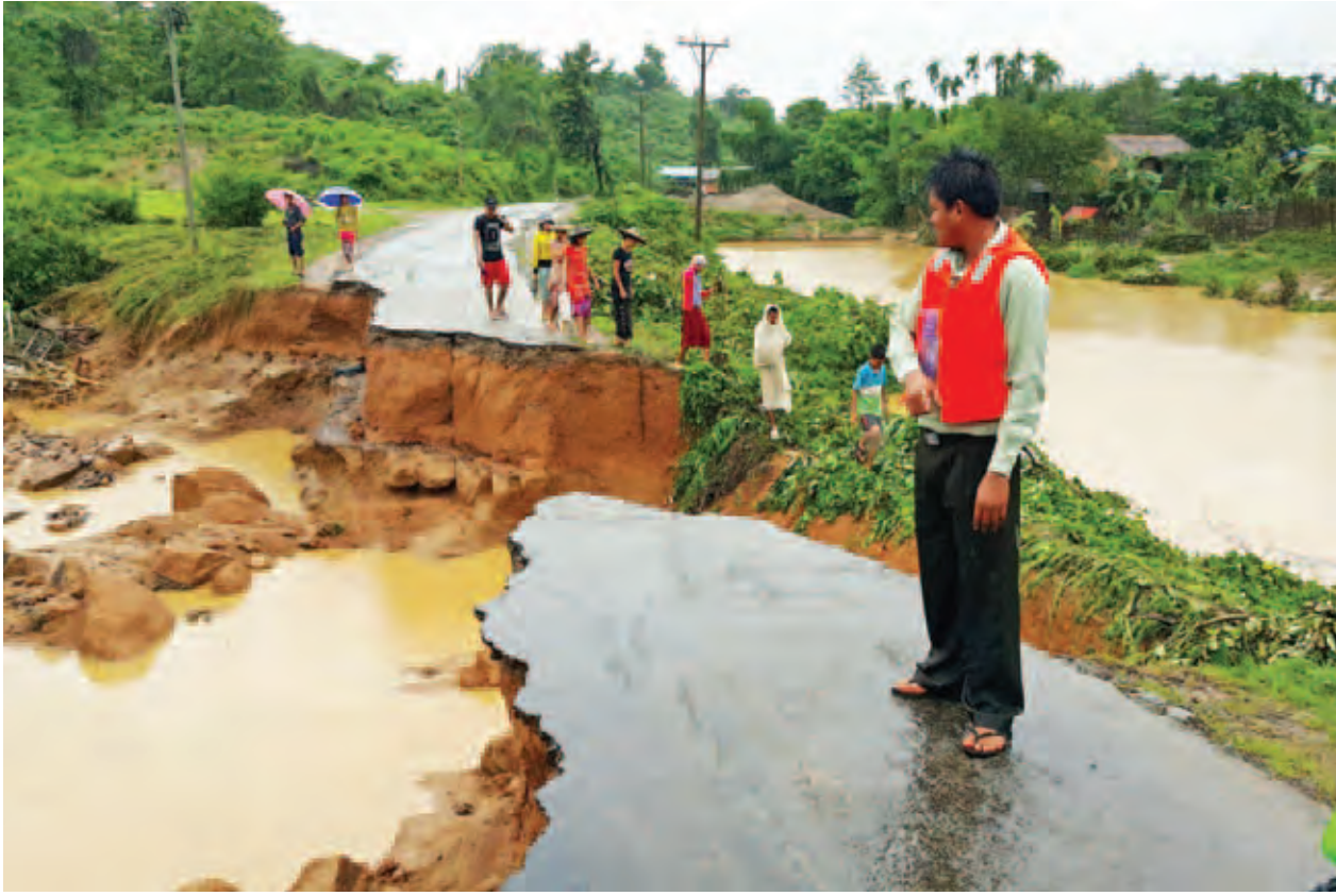
အမ်း-စစ်တွေလမ်းပိုင်း အမ်းမြို့အတွက်နေရာတွင် ကတ္တရာလမ်းပျက်စီးမှုအခြေအနေကို တွေ့ရစဉ်။
