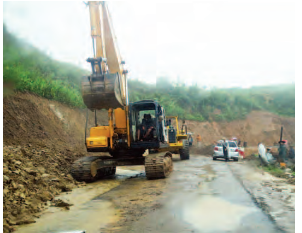
မိုင်တိုင်အမှတ် (၆၂/၄) နှင့် (၆၂/၅)အကြားတွင် တောင်မြို့ပြီး လမ်းနိမ့်ကျပျက်စီးခြင်းကို ပြန်လည်ပြုပြင်နေစဉ်။ (ဆောက်လုပ်ရေး)
