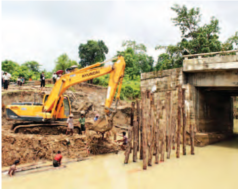
တောင်ကုတ်-ကျောက်ဖြူလမ်း မိုင်တိုင်အမှတ် (၁၄/၆)၊ တံတားအမှတ် (၃/၁၂) ပျက်စီးမှုအား လမ်းအထူးအဖွဲ့ (၁၈)မှ ယန္တရားများဖြင့် ပြင်ဆင်ဆောင်ရွက်မှုကို တွေ့ရစဉ်။ (နယ်စပ်ရေးရာ)
