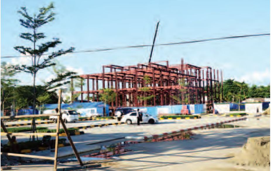
မြောက်ဥက္ကလာပမြို့နယ် ကန်သာယာပန်းခြံ၌ အဆောက်အအုံအချို့တည်ဆောက်နေမှုကို တွေ့ရစဉ်။
