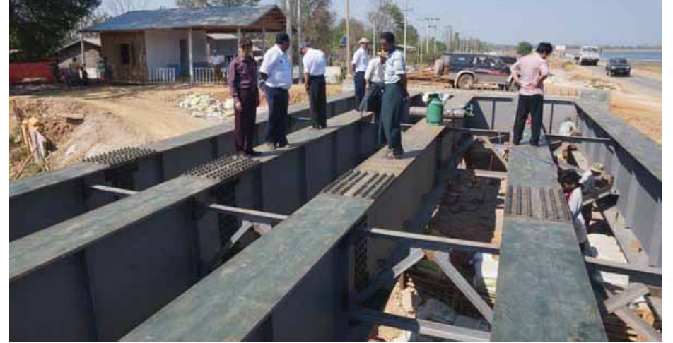
ဘောင်ရှောင်ကွင်းလမ်း၊ အရှည် ၁၂၀ ပေ၊ နှစ်လမ်းသွား သံကူကွန်ကရစ်တံတားနှင့် ငွေတောင်ဆည်တာဘောင်ရှောင်ကွင်းလမ်း ပေး၆၀၀ အား ကတ္တရာလမ်း ဆောင်ရွက်နေမှုအားလည်းကောင်း သွားရောက်ကြည့်ရှုစစ်ဆေးခဲ့ကြောင်း သိရသည်။
