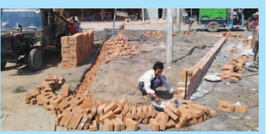
၂၀၁၄-၂၀၁၅ ဘဏ္ဍာရေးနှစ် ပြုပြင်ပြီးရန်ပုံငွေဖြင့် မြင်းမူမြို့ သစ္စာလမ်း(သင်္ဘောဆိပ်လမ်း)၊ ကတ္တရာထပ်ပိုးလွှာခင်း ခြင်း၊ သစ္စာလမ်းနှင့် ဂန္ဓာမာလမ်းထောင့် ကြိတ်ပုံမြေလှိုင်းကျင်းတူးပြီး ခဲကျိုးရိုက်ထည့် အုတ်စီခြင်းလုပ်ငန်းကို မတ် ၁ ရက်က စတင်လုပ်ကိုင်လျက်ရှိရာ ကြိတ်ပုံ၏အရှေ့ဘက်ခြမ်းဘေး၊ ဂန္ဓာမာလမ်းထပ်မှ သစ္စာလမ်းထိဆက်ကာ ယခင်မြေသား လမ်းအားအဆင့်မြှင့်တင်သွားမည်ဟု စည်ပင်သာယာရေးတာဝန်ခံအင်ဂျင်နီယာ ဦးအောင်အောင်ဦးက ပြောသည်။ အဆိုပါ သစ္စာလမ်းနှင့် ဂန္ဓာမာလမ်းထောင့်ရှိ ကျူးကျော်ဆိုင်များကို ဖေဖော်ဝါရီ ၂၆ ရက်တွင် ဖယ်ရှားရှင်းလင်းခဲ့ကြောင်း သိရ သည်။ သတင်းနှင့် ဓာတ်ပုံ - (၆၂၄)
