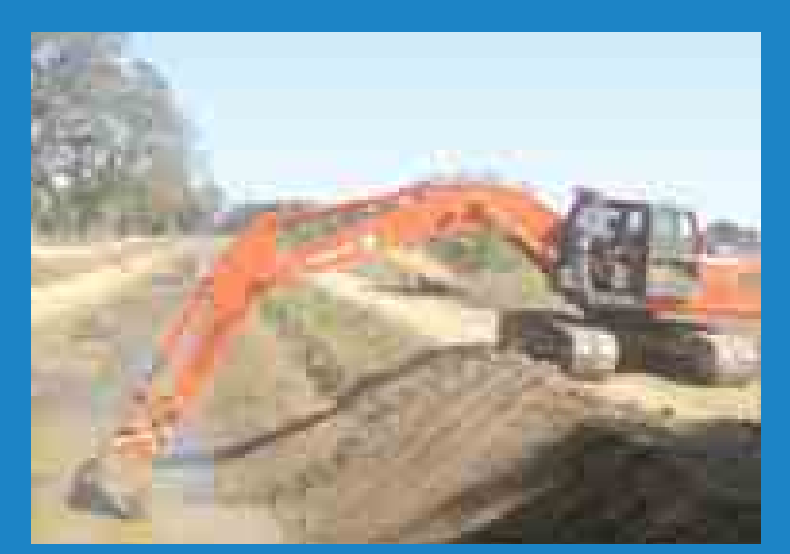
မကွေးတိုင်းဒေသကြီး ပွင့်ဖြူမြို့နယ် ဆည်မြောင်းဦးစီးဌာနမှ မဲဇလီရေလွှဲဆည်မှတစ်ဆင့် ဖို့လွှတ်သော တောင်မှန်းမြောင်းမကြီးနှင့် မြောက်မှန်းမြောင်းမကြီး နှစ်သွယ်တွင် ရေစီရေလာကောင်းမွန်စေရန်အတွက် Hitachi Backhoe စက်ကြီးများဖြင့် သဲနုန်းဆယ်ခြင်း၊ ပြေသားပေါင်များ ထပ်ဆင့်ပေးခြင်းများ ဆောင်ရွက်လျက်ရှိရာ ပွင့်ဖြူမြို့နယ်အတွင်းရှိ နေ့စပါးစိုက်တောင်သူများ စိုက်ပျိုးရေး အပြည့်အဝ ရရှိမည်ဖြစ်ပြီး မဲဇလီ ရေလွှဲဆည်မှ ဖေဖော်ဝါရီ ၇ ရက်တွင် ဆည်ရေစတင် လွှတ်ပေးနိုင်ရန် စီစဉ်လျက်ရှိကြောင်း သိရသည်။ သတင်းနှင့်စာတတ်ပုံ- တင်ထွန်းဦး(မင်းဘူး)
