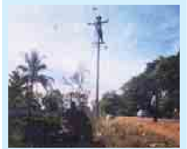
ရန်ကုန်မြို့တော်လျှပ်စစ်ဓာတ်အားပေးရေးအဖွဲ့မှ အများပြည်သူဓာတ်အားပြည့်ဝစွာသုံးစွဲနိုင်ရေး၊ ဓာတ်အား မပြတ်တောက်ရေး၊ လျှပ်စစ်အန္တရာယ်ကင်းရှင်းရေးအတွက် ကြိုးပမ်းဆောင်ရွက်လျက်ရှိရာ ဒီဇင်ဘာ ၂၁ ရက်က ဥက္ကံမြို့ မင်းရဲကျော်စွာရပ်ကွက် ပြည်လမ်းရှိ ၁၁ ကေဗီ လမ်းချိမ့်ဒါ၏ ACSR 35 mm² ကြိုးဆိုင်အသေးများအား ACSR 95 mm² ကြိုးဆိုင်ကြိုးများဖြင့် အစားထိုးလဲလှယ်ခြင်းလုပ်ငန်းကို ဥက္ကံမြို့ လျှပ်စစ်အင်ဂျင်နီယာ ဦးသိုက်ဖိုးနှင့် လိုင်းဝန်ထမ်းများ ဆောင်ရွက်နေစဉ်။
