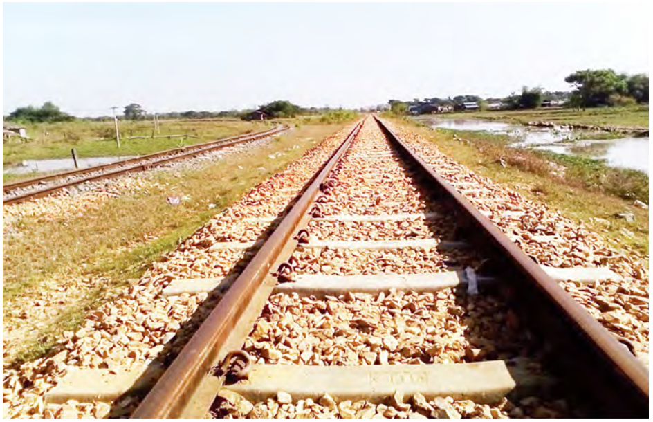
အုတ်ဖိုစု - သီလဝါဘူတာကြား ရထားသံလမ်းဆက်ကြောင်းများ ဆွဲညှိခြင်းနှင့် ကွန်ကရစ်လီမားတုံးအသစ် များ လဲလှယ်ထားစဉ်။
