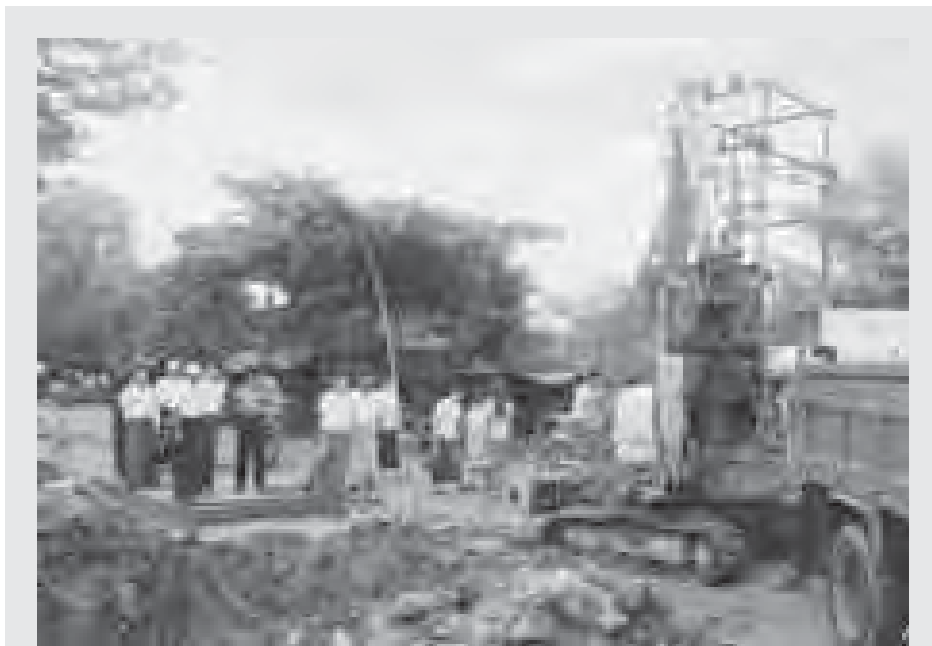
ဒလ-တွဲတားကားလမ်းမကြီးပေါ်ရှိ ဒလ-ကျိုက်စုခတ်ကားလမ်းမ (ဗိုလ်တေလမ်းမ) အား လမ်းတစ်ဖက်လျှင် အကျယ် ၆ ပေ၊ ၇ လက်မ ရှေ့တွင်၍ လမ်းအရှည် ၈၀၀ အား ကွန်ကရစ်လမ်းခင်းဖြင့်၊ ရေမြောင်းဖောက်ခြင်းလုပ်ငန်းများ ဆောင်ရွက် လျက်ရှိရာ မြို့နယ်အထောက်အကူပြုအဖွဲ့ဥက္ကဋ္ဌ ဦးတင်လှိုင်နှင့် အဖွဲ့ဝင်များ၊ တာဝန်ရှိသူများက အောက်တိုဘာ ၂၅ ရက်က ကြည့်ရှုစစ်ဆေးခဲ့ကြသည်။ သတင်းနှင့် ဓာတ်ပုံ - မင်းရဲမာန် (နေပြည်တော်)
