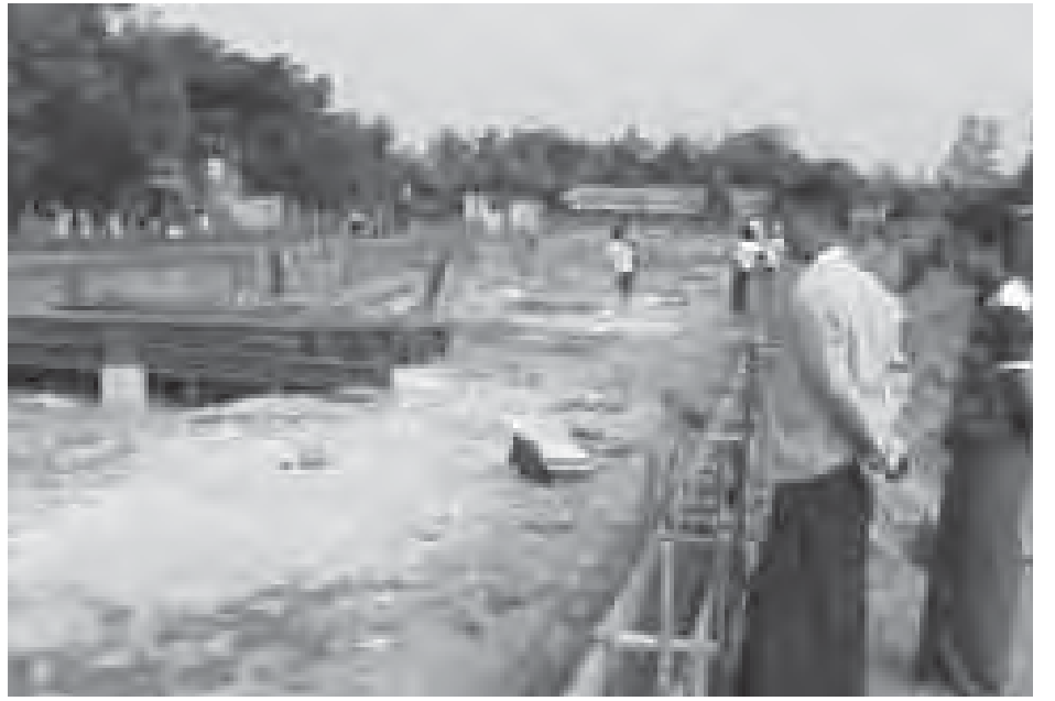
အောက်တွင် နားနေမှုအဆင်ပြေလာမည်ဖြစ်သည်။ အဆိုပါ ကားကြီးဝင်းအဆောက်အအုံသစ် ဆောက်လုပ်နေမှုကိုအမြန် ဆုံးပြီးစီးနိုင်ရေးအတွက် ကလေးမြို့နယ် စည်ပင်သာယာရေးကော်မတီတို့နှင့် ဦးမောင်ထူးသည် ကလေးမြို့နယ် ဖွံ့ဖြိုးတိုးတက်ရေး အထောက်အကူပြုကော်မတီနှင့် ကလေးမြို့နယ် စည်ပင်သာယာရေးကော်မတီတို့နှင့် အတူအနီးကပ် ကြီးကြပ်နေကြောင်း သိရသည်။ ဂျီ၊ နတ်
