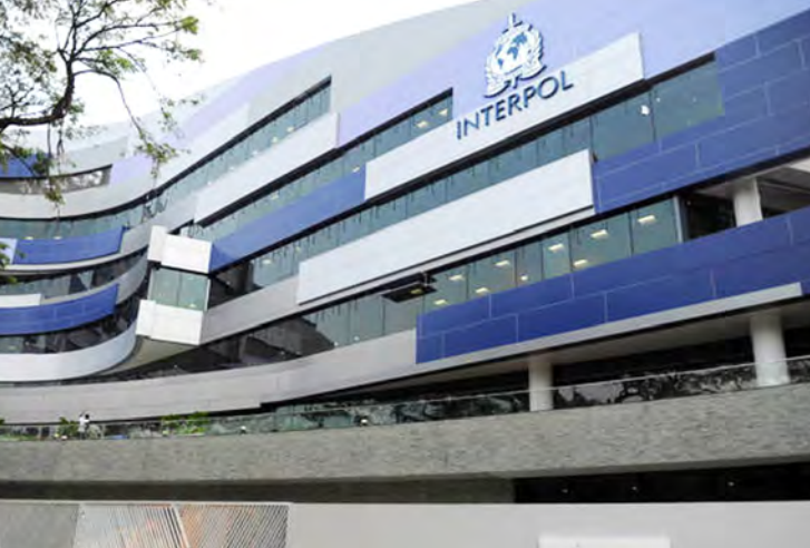
စင်ကာပူ၌ ဖွင့်လှစ်မည့် ဆိုင်ဘာမူခင်းတိုက်ဖျက်ရေးဆိုင်ရာ အင်တာပိုလ်ရုံး အဆောက်အအုံသစ်ကို တွေ့ရစဉ်။
