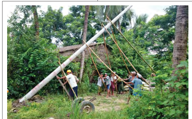
ကျောက်တန်းမြို့နယ် တံတားမြို့ အမှတ်(၁)ရပ်ကွက်အတွင်း ဓာတ်အား ဖြန့်ဖြူးထားသော ဓာတ်အားလိုင်ရီ ဆွေးမြည့်သစ်သားတိုင်များအား တွန်ကရစ် တိုင်များဖြင့် အစားထိုးလဲလှယ်ခြင်းလုပ်ငန်းကို မြို့နယ်လျှပ်စစ်အင်ဂျင်နီယာ ဦးဖြိုးဇော်သိန်းနှင့်အဖွဲ့ စက်တင်ဘာ ၂၄ ရက်က ဆောင်ရွက်စဉ်။ (၆၈၉)
