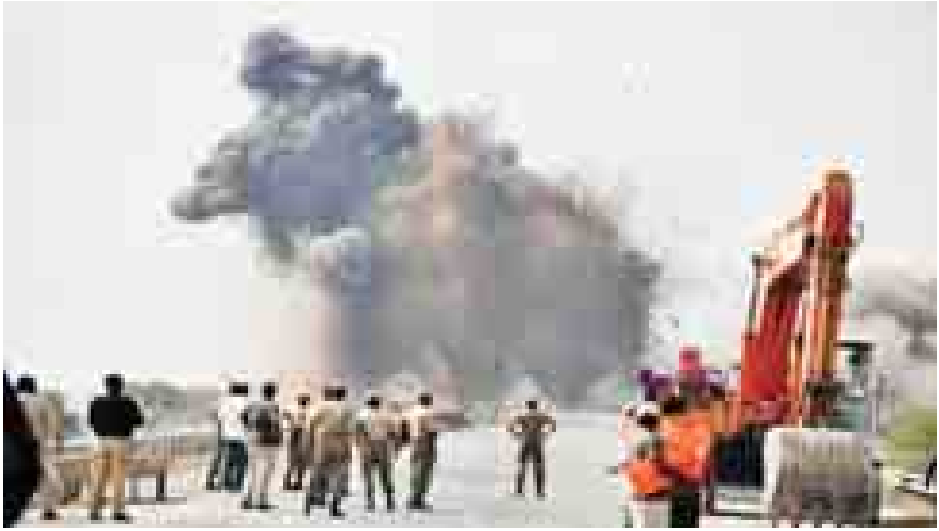
ရေကြီးနေသောမြစ်မှ ရေကိုခွဲဖြားစီးဆင်းစေရန် စစ်ဘက်အင်ဂျင်နီယာများက တာတမံများကို ဖောက်ခွဲဖျက်ဆီးကြစဉ်။
